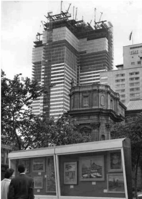
Fig. 4. Montréal, une exposition de tableaux en plein air, avec le chantier de Place Ville-Marie en arrière-plan, 1961. © Jeremy Taylor.
