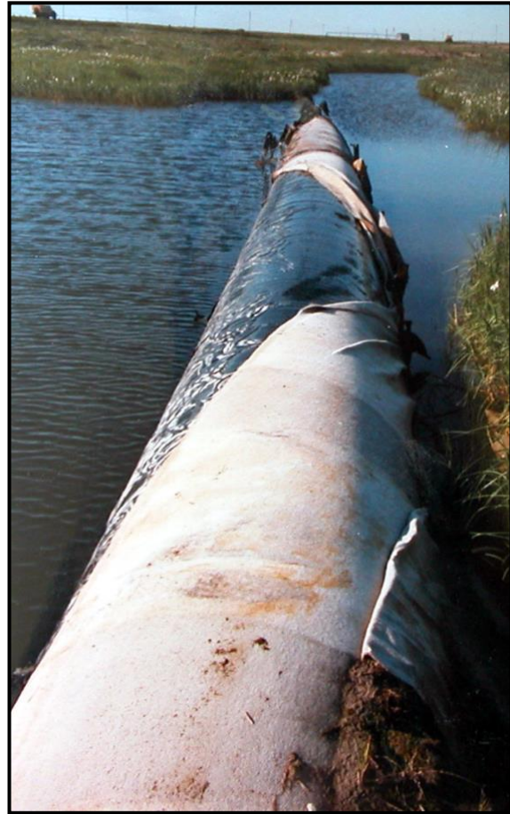
Un oléoduc mal/pas isolé a fait fondre le pergélisol et trempe, dans un bulbe de dégel, accélérant sa propre corrosion. Photo : © Y. Vaguet
