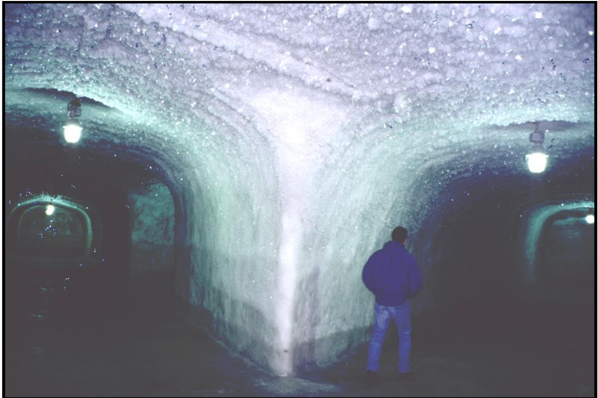
Fig. 38. Anciennes réserves alimentaires de la base de Iambourg creusées dans le pergélisol
