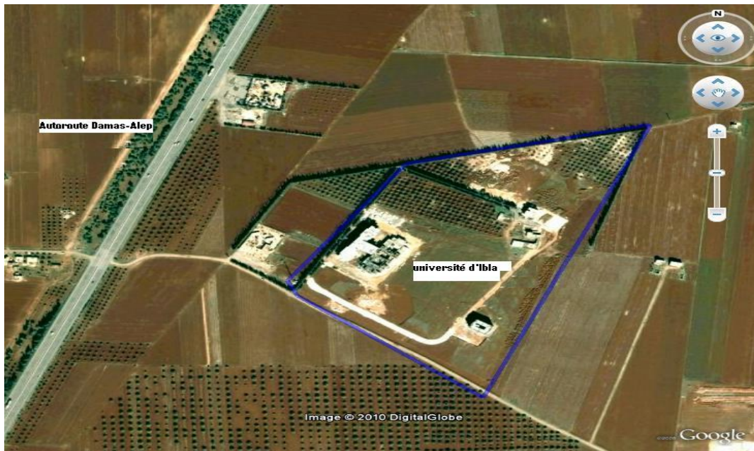
Figure 30: Le site de l'université d'Alyarmouk qui se localise à proximité de l'autoroute Damas-Alep.
