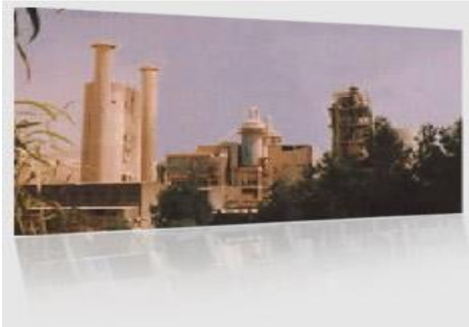
Figure 34: la cimenterie d'Adra
