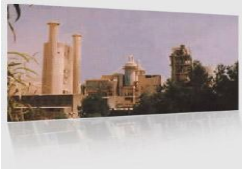
Figure 34: la cimenterie d'Adra
