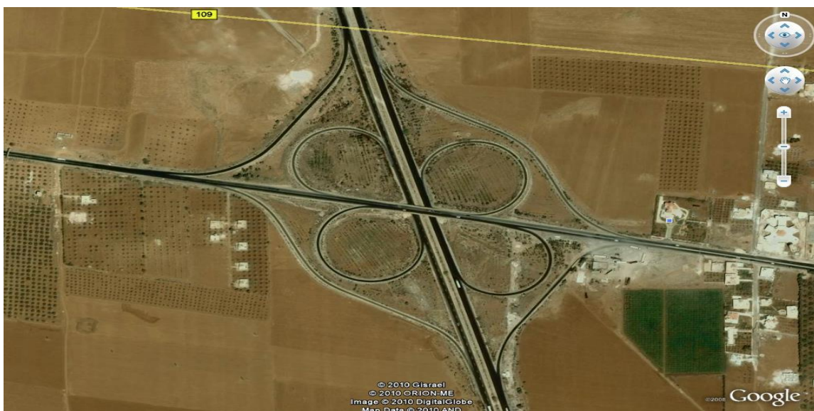
Figure 9 : L'échangeur de Saida-Deraa. Sur l'autoroute Damas-Amman qui devient complet (il permet d'entrer et de sortir de l'autoroute dans les deux sens)
