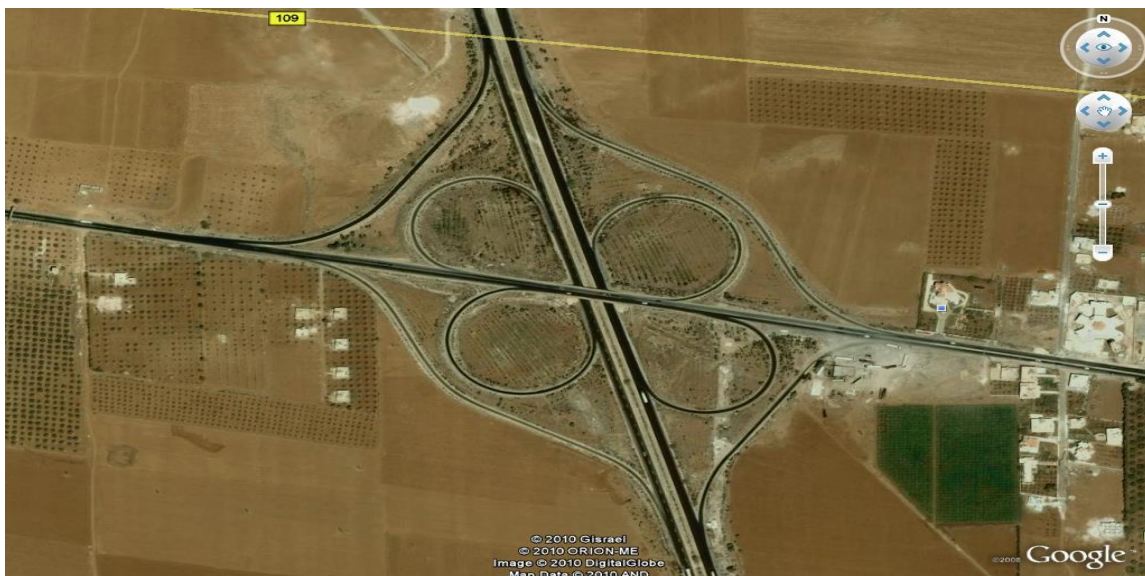
Figure 9 : L'échangeur de Saida-Deraa. Sur l'autoroute Damas-Amman qui devient complet (il permet d'entrer et de sortir de l'autoroute dans les deux sens)
