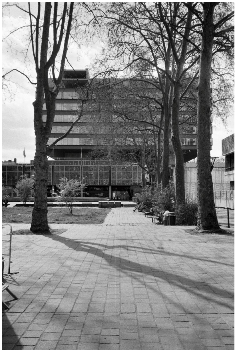
Rue du lac en chantier, siège de la Métropole de Lyon
