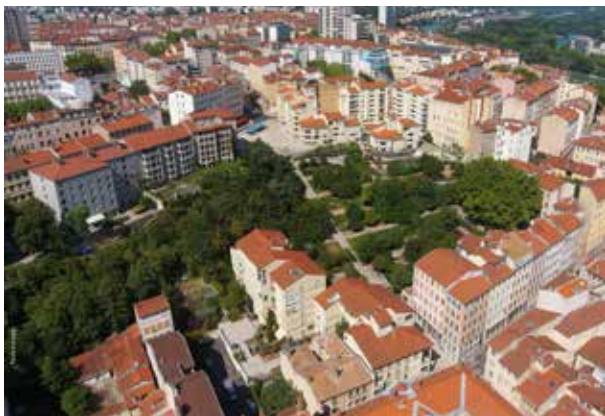
Parc Montée de la Grande Côte ©Technivue
