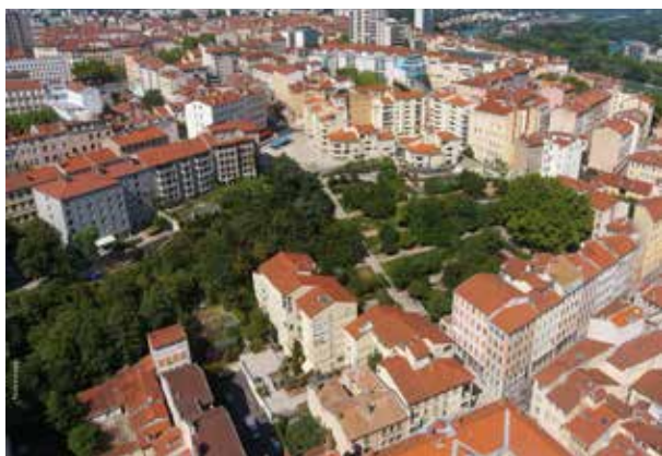
Parc Montée de la Grande Côte ©Technivue
