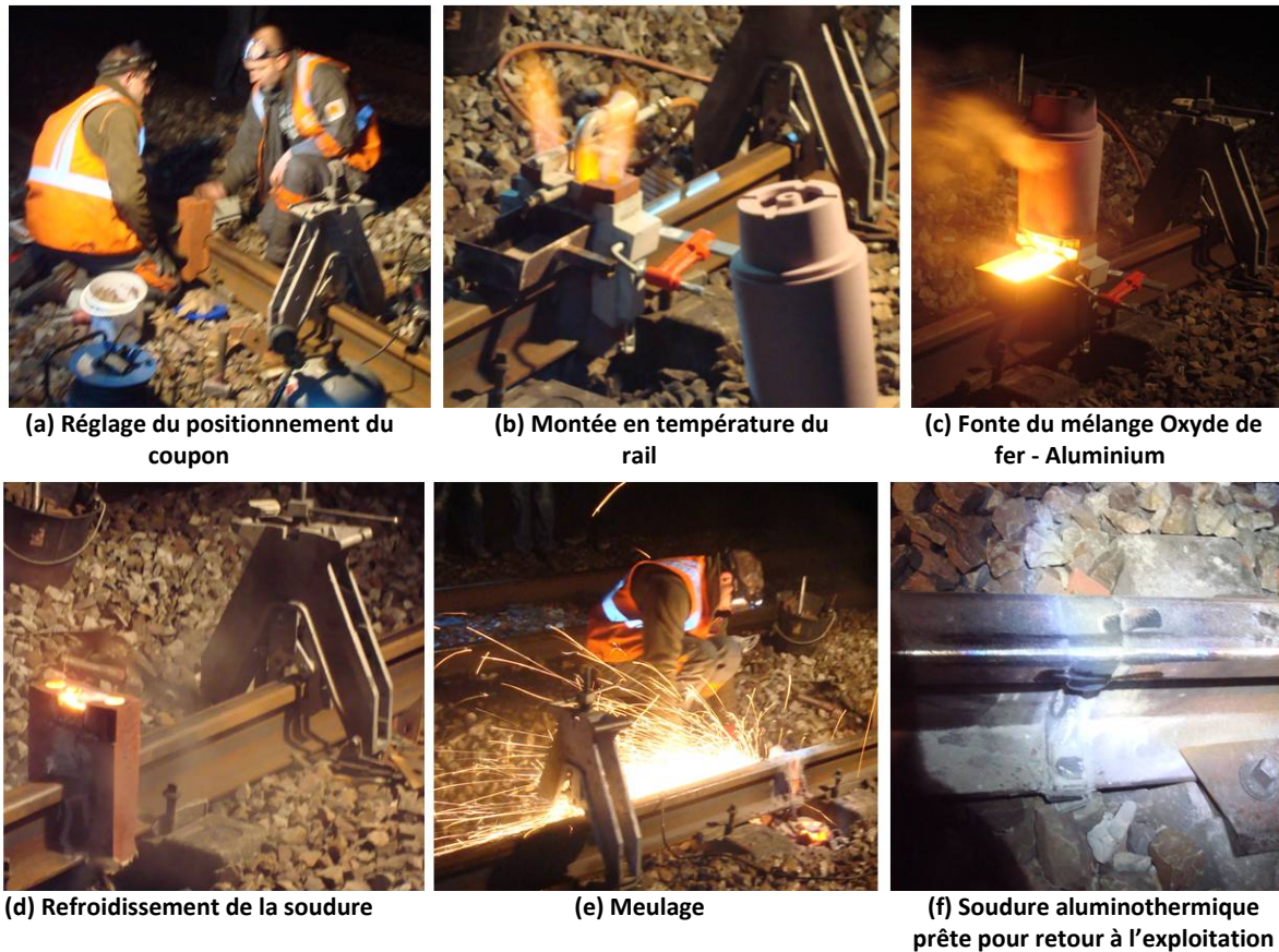
Figure 38 : Réalisation d'une soudure aluminothermique sur le RER A
