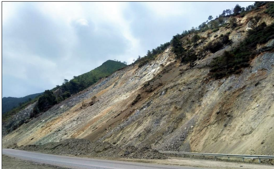
Photo 6 : Glissement profond d'un versant boisé dans le massif des péridotites de Beni Bousera.
