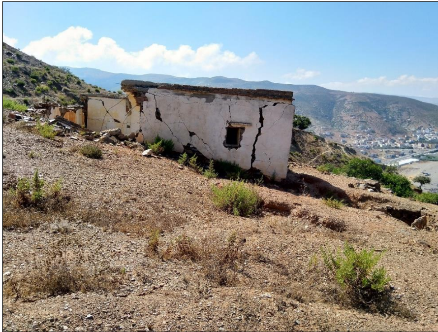
Photo 1 : Destruction d'une maison élevée sur un glissement de terrain ancien
