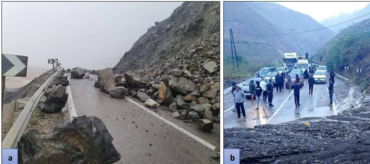
Photo 8 : Coupures de la route nationale N 16 par des mouvements de terrain pendant des journées de pluies intenses. a) éboulement de roches causant la coupure totale de la route au niveau de la sortie Est du village Targha (date de déclenchement : 24/03/2020). b) coulée de boue causant la coupure du tronçon routier entre Amtar et Aaraben (date de déclenchement : 22/09/2021)
