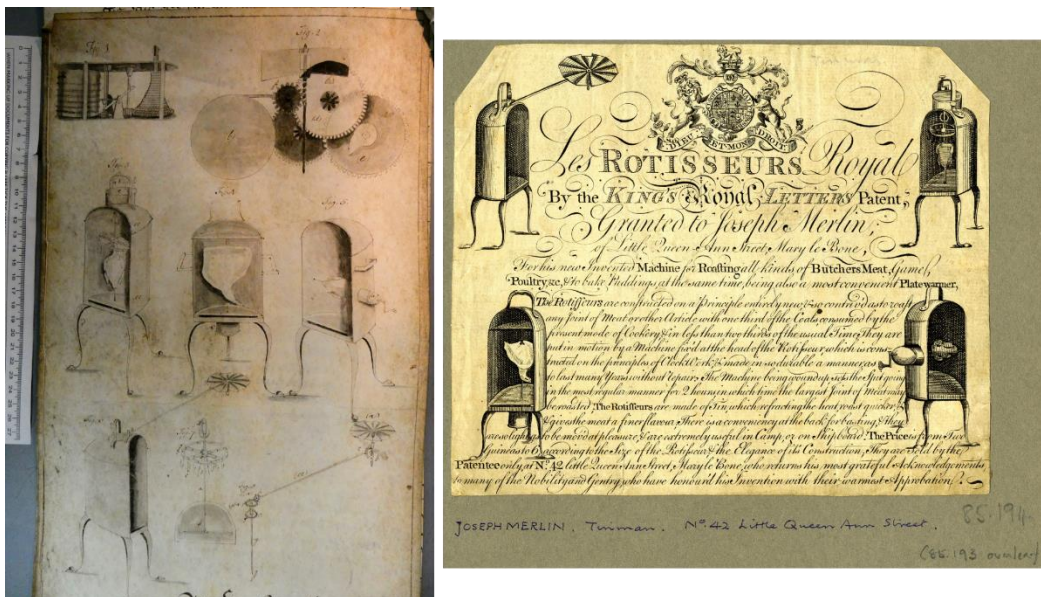
Illustration 20. Gauche : Patent n°1032, « Roasting Jack », Joseph Merlin, 1773, TNA C 210/13. Photo de l'auteur ; droite : trade card, Les Rotisseurs Royal, 1773. © The Trustees of the British Museum.
