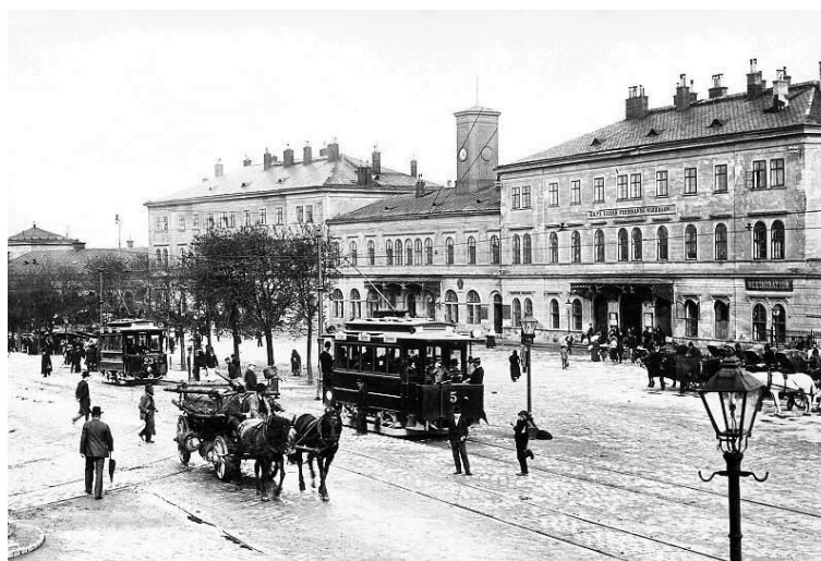
Figure 164. A Brno, les tramways et leurs voies, enregistrées en 1901 devant la gare centrale, témoignent d'un réseau de tramway continuellement exploité depuis plus d'un siècle (source : Wikimedia).
