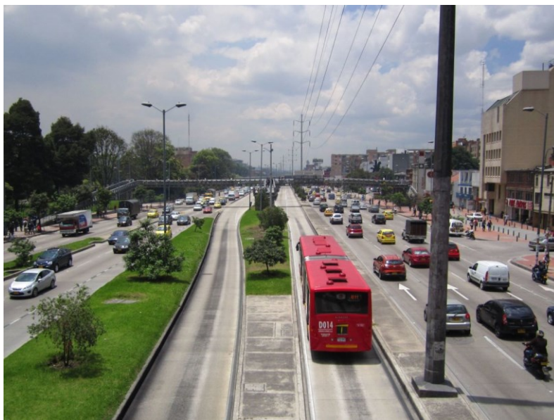
Figure 63. Lors de la mise en place du Transmilenio , système de BHNS à Bogotá, une attention est accordée à l'aspect de l'insertion urbaine des nouvelles infrastructures (source : brt.strikingly.com).
