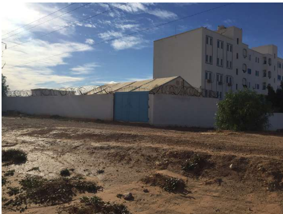
Photo 17 : Mur d'enceinte du centre du HCR à Médénine. Auteur : Camille Cassarini, 2019.
