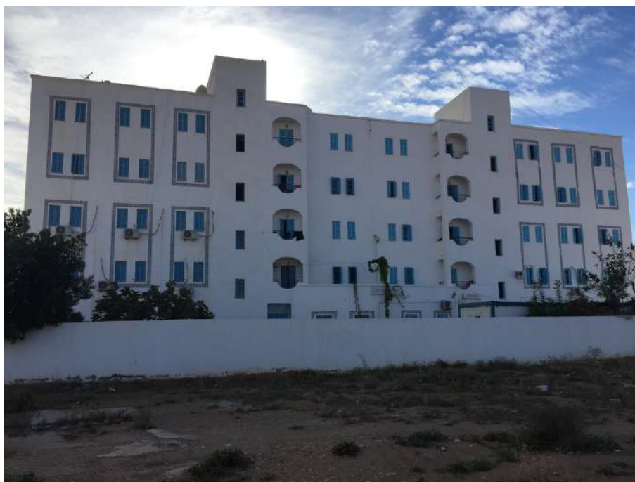
Photo 18 : Façade sud du centre du HCR à Médénine. Auteur : Camille Cassarini, 2019.
