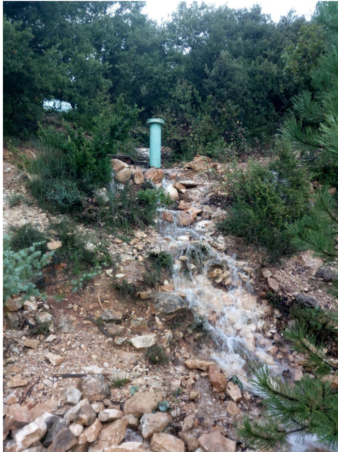
FIGURE 3.13 – Écoulement de surface observé lors du suivi temporel RMP post épisode pluvieux. Cet écoulement est localisé en bordure de boucle.
