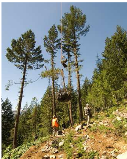
Photo. 37 : Évacuation des déchets et du matériel par hélitreuillage
