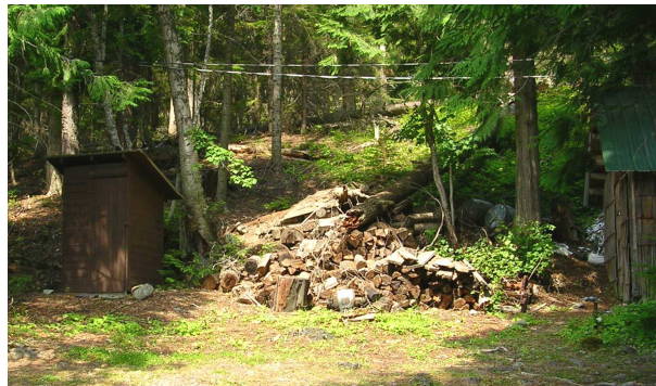
Photo. 45 : Ruine d'un chalet après son acquisition par le NPS (Kelly Camp, Glacier)
