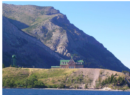
Photo. 3 : Vue d'ensemble autour de l'hôtel
