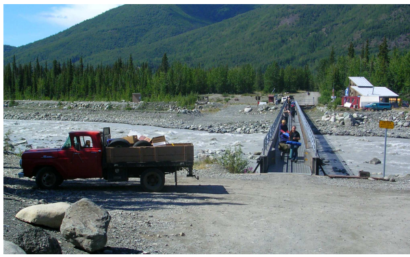
Photo. 43 : Le pont piéton public de McCarthy
