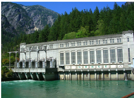
Photo. 20 : Barrage de la Gorge
