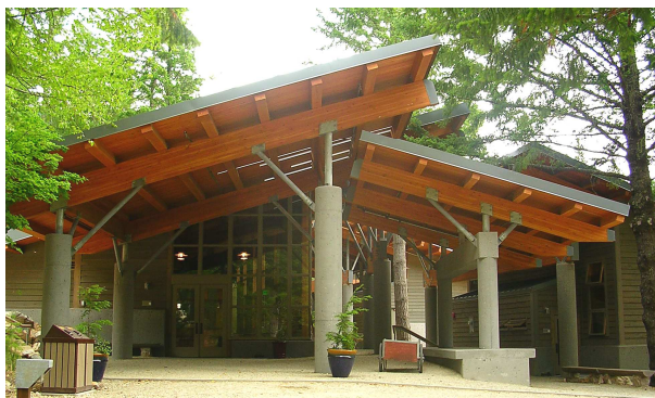
Photo. 25 : Entrée du bâtiment principal
