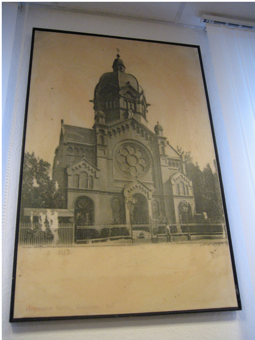
Figure 17 : Photographie de la synagogue de Cottbus détruite en 1938. Cette photographie figure dans la salle principale de la Communauté juive de la ville. Elle demeure le symbole de cette Communauté juive. Photographie : L. Vapné. Février 2007.
