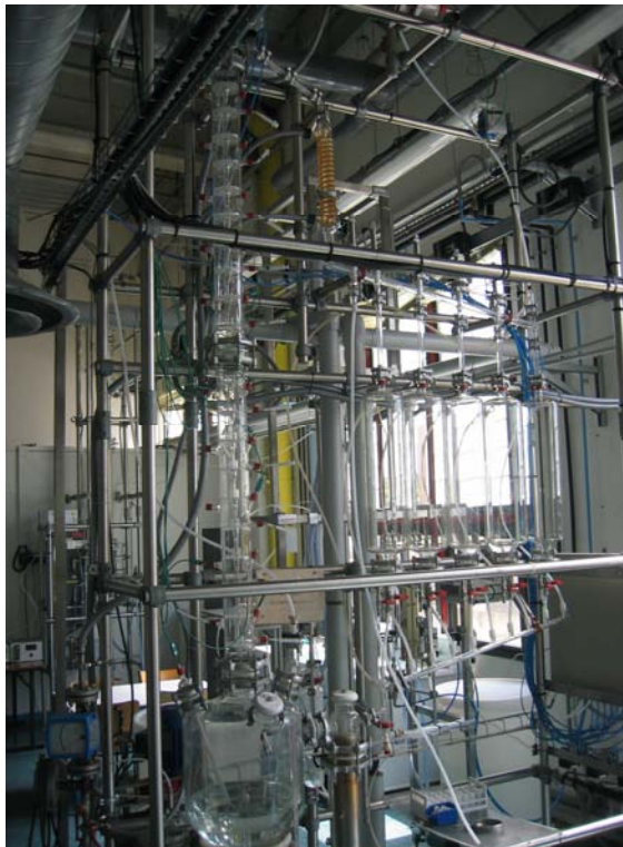
colonne à distiller discontinue à l'AIGEP
