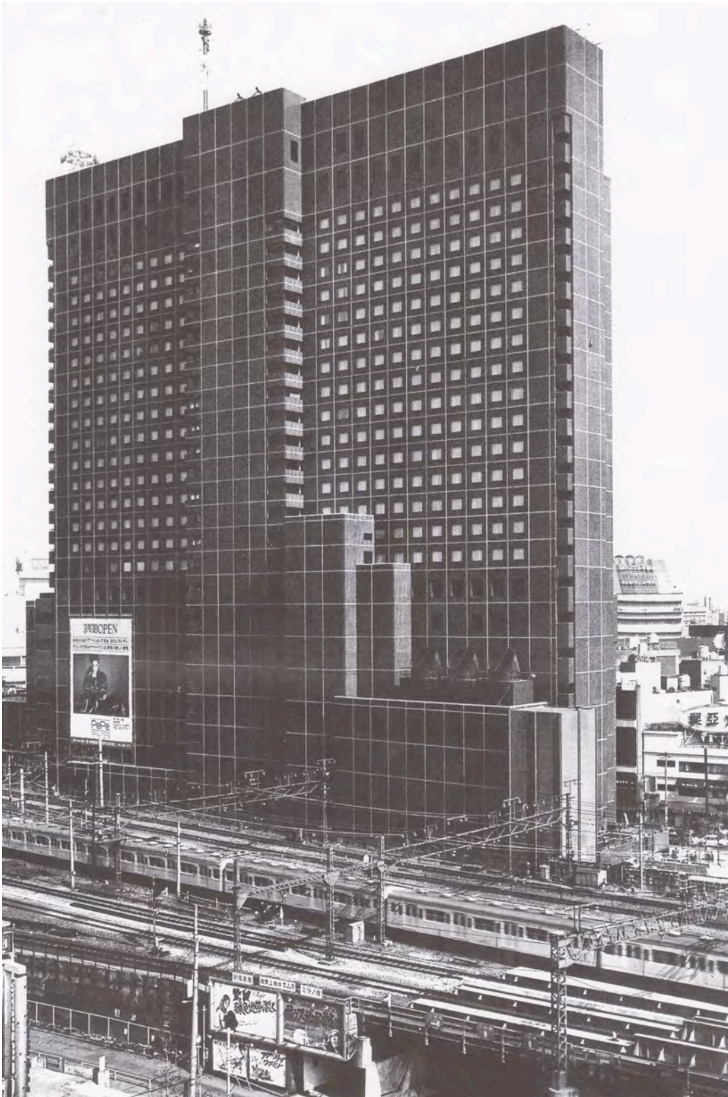
Figure 99 (a) : Vue de la façade ouest du bâtiment-gare Seibu Shinjuku à Tôkyô conçu par Shimizu kensetsu / Shimizu Corporation et livré en 1977
