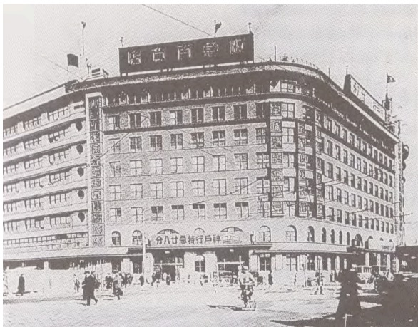
Figure 90 (b) : Vue de la façade principale du grand magasin du bâtiment-gare Hankyū Umeda à Ôsaka édifié en 1929 et situé dans l'axe de l'avenue Midōsuji
