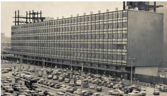
Figure 92 (a) : Vue de la façade de la nouvelle aile est Yaesu de la gare centrale de Tôkyô construite en 1953 et en cours de surélévation en 1954
