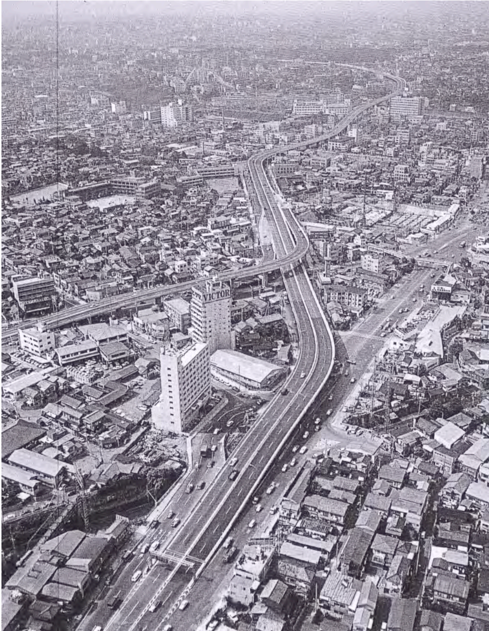
Figure 22 : Vue cavalière de l'autoroute urbaine n° 2 près du site de Gotanda, en direction du centre de Tôkyô, en 1970
