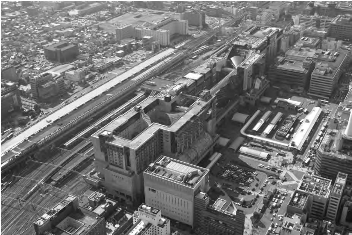
Figure 47 : Vue cavalière de la gare de Kyôto depuis le nord-est en 2008
