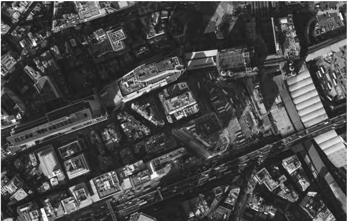
Figure 51 : Vue aérienne de l'opération Shibuya Mark City à Tôkyô en 2011 (orientation au nord)
