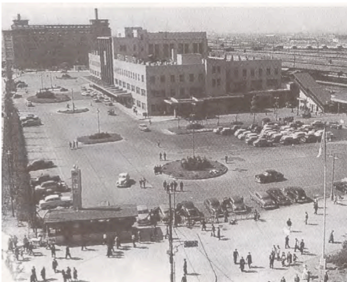
Figure 88 : Vue latérale vers l'ouest de la 3 e gare d'Osaka (Umeda) achevée en 1940
