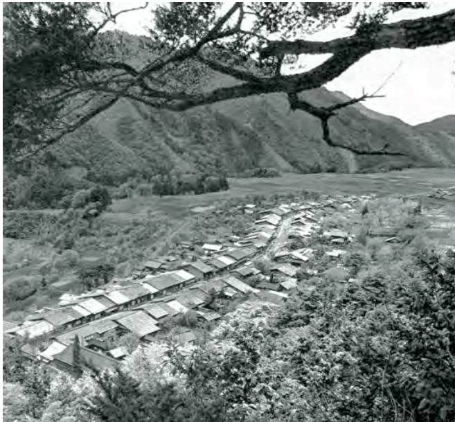
Figure 55 : Vue cavalière d'un bourg d'étape de la Kisho kaidô dans la préfecture de Nagano
