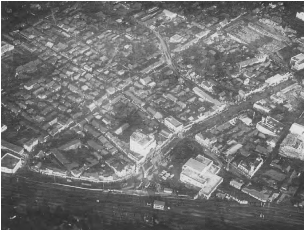
Figure 86 (c) : Vue d'avion vers le nord-est en 1928 de la gare de Shinjuku implantée en retrait de Shinjuku-dôri à Tôkyô
