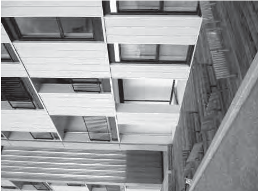
Photo 3 – Clôture illégale de terrasse privative (Source : J. Boissonade, 22/11/2010)
