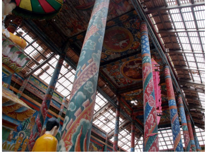
ill. 8 – Vat Khna, 141209-2. 1934 et années 1960 travaux en 2010
