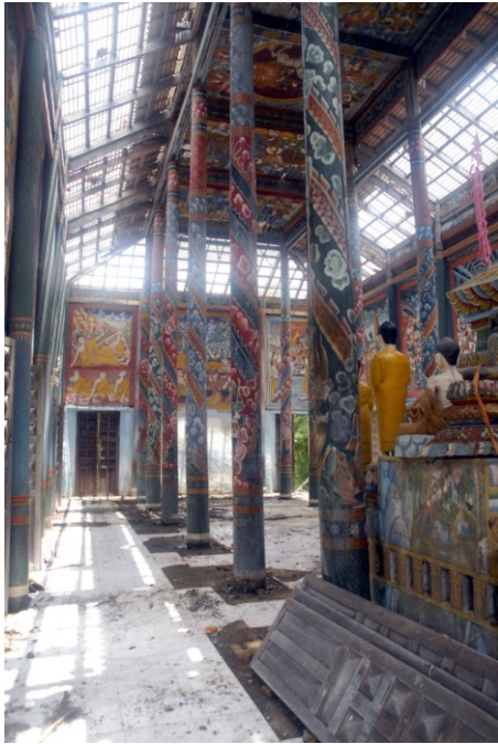
ill. 7 – Vat Khna, 141209-2. 1934 et années 1960 travaux en 2010
