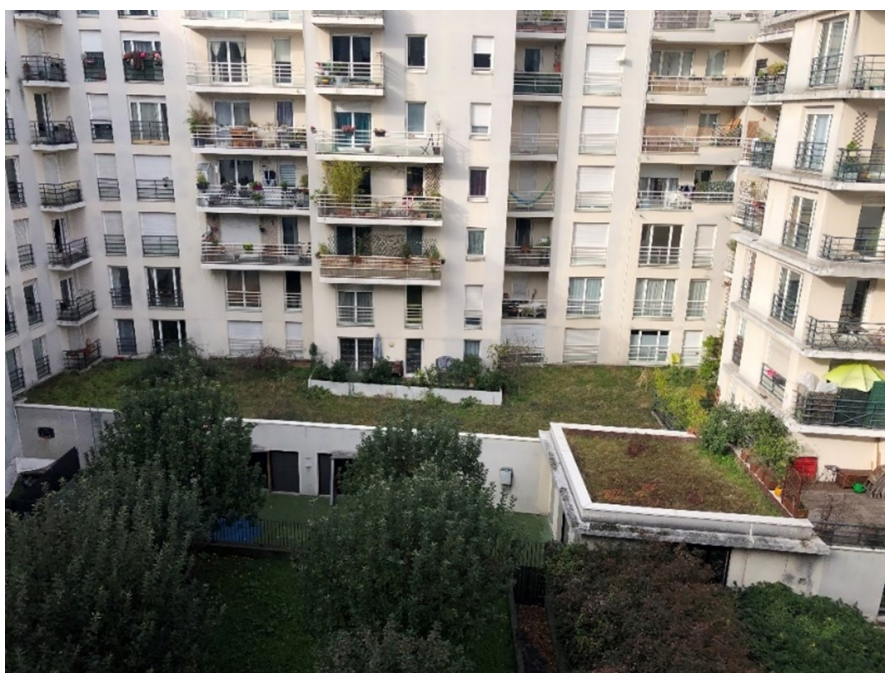
FIGURE 3.2 – Exemple d’une toiture végétalisée dans Paris de faible hauteur (inférieure à 10 mètres) potentiellement isolée et entourée de bâtiments supérieurs à 20 mètres.
