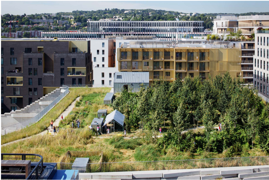
FIGURE 10 – Photo (copyright ph. Guignard – VDSA 2017.) de l'école des sciences et de la biodiversité à Boulogne-Billancourt, exemple de toiture végétalisée intensive accessible.
