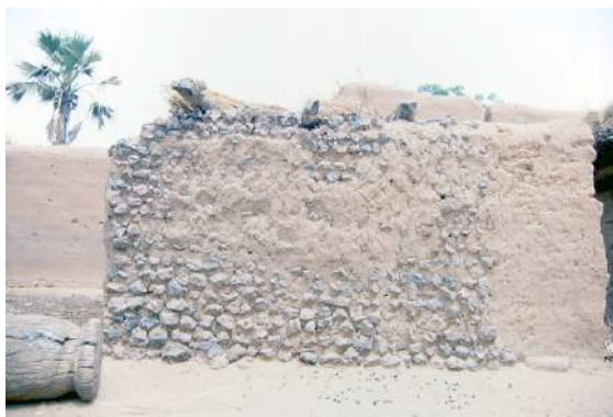
Fig. 193 : Réemploi des scories de fond sableuses dans la construction des maison d'Iribanga.
