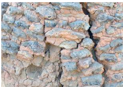
Fig. 118 : Paroi externe construite à l'aide de scories de fond sableuses.
