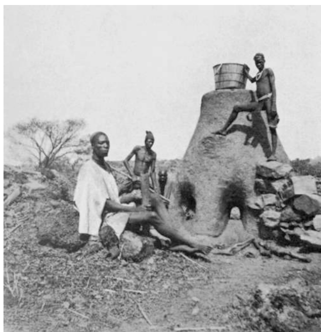
Fig. 2 : Bas fourneaux et métallurgistes dogon mimant les différentes étapes de la réduction du minerai de fer (confection d'une tuyère, charge du minerai de fer ou du charbon de bois porté dans un panier, et décharge de la loupe de fer à l'aide d'un long bâton). Cette photographie fut prise dans le sud du plateau dogon, région Haroua ou Arow (Desplagnes 1907 : planche LV).
