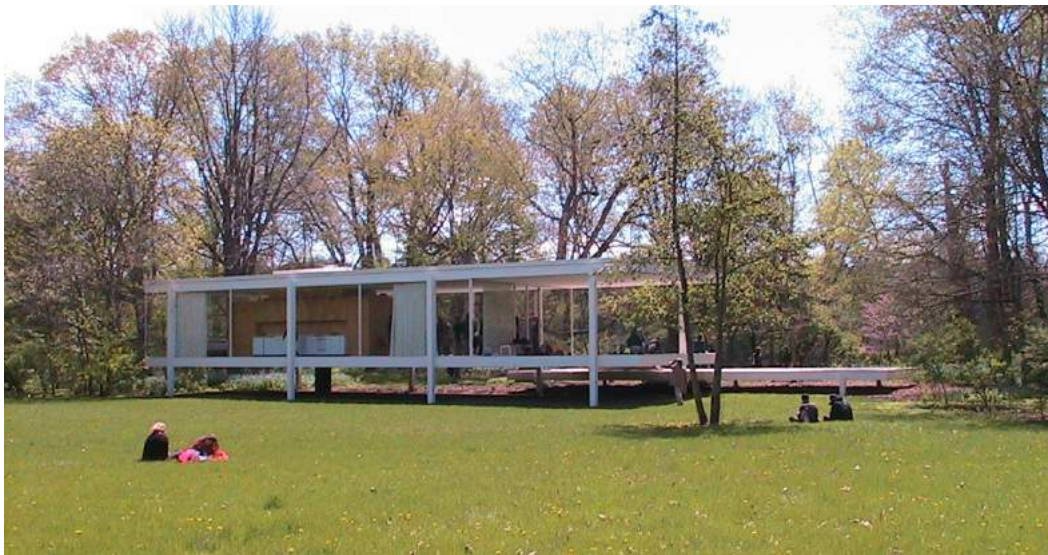
Figure 30 : Ludwig Mies van der Rohe, Villa Farnsworth, Plano, Illinois. Photographie Alain Dervieux, 2005.
