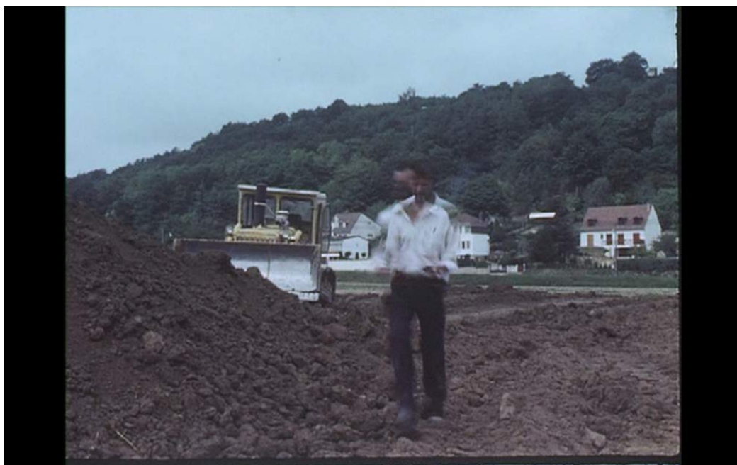
Figure 97 : Jacques Simon modelant les remblais du parc Saint John Perse, 1973. L'utilisation de 40 000 m, tient lieu de programme. Jacques Simon réalise ici un « parc-esquisse » : un ourlet planté autour d'une clairière en cuvette, une chambre verte. » (In Les annales de la Recherche Urbaine n° 85 – Paysages en Ville, éd. Plan Urbanisme Architecture, 2000)
