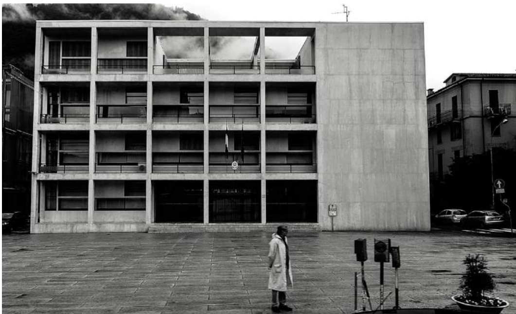
Figure 184 : casa del Fascio, de Giuseppe Terragni à Côme, 1932-36, photographie Lorenzo Pica.
