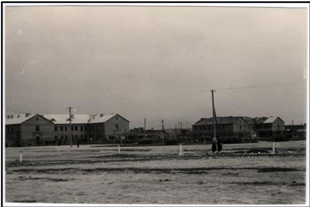
Source : Archives audiovisuelles du CICR, en ligne, V-P-HIST-03183-20A, « Guerre 1939-1945. Rawa-Ruska / Lemberg, Stalag 325. Vue générale avec casernes construites pour les prisonniers de guerre russes », août 1942.
