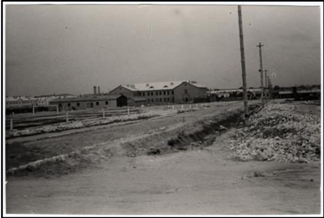
Source : Archives audiovisuelles du CICR, en ligne, V-P-HIST-03183-23A, « Guerre 1939-1945. Rawa-Ruska / Lemberg, Stalag 325. Vue générale avec casernes construites pour les prisonniers de guerre russes », août 1942.
