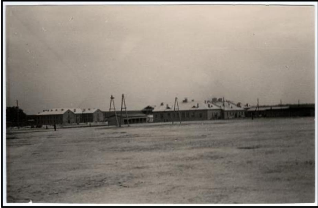
Source : Archives audiovisuelles du CICR, en ligne, V-P-HIST-03183-19A, « Guerre 1939-1945. Rawa-Ruska / Lemberg, Stalag 325. Vue générale avec casernes construites pour les prisonniers de guerre russes », août 1942.
