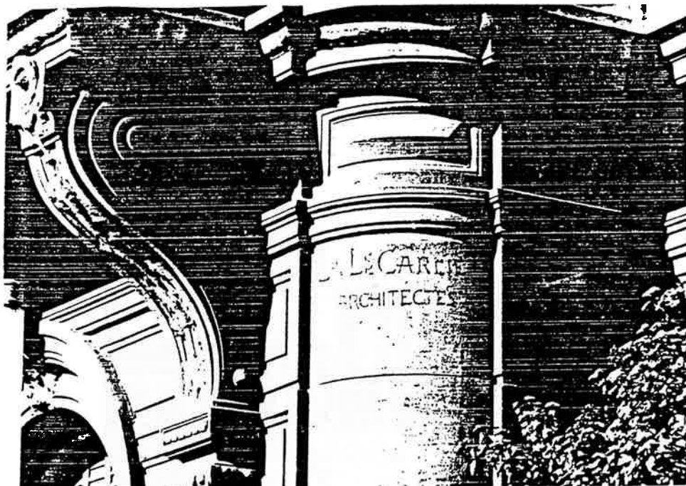
Cl. 93 - Façade sud-est de l'Hôtel Bulher (59, avenue Saint-Saëns à Réziers) construit par Louis et Léopold Carlier (1903).
