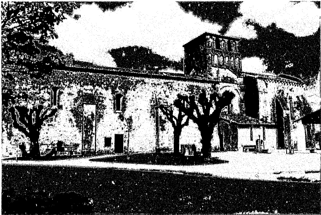
Fig. 2 : Saint-Martial-de-Mirambeau. Vue générale depuis le sud.
