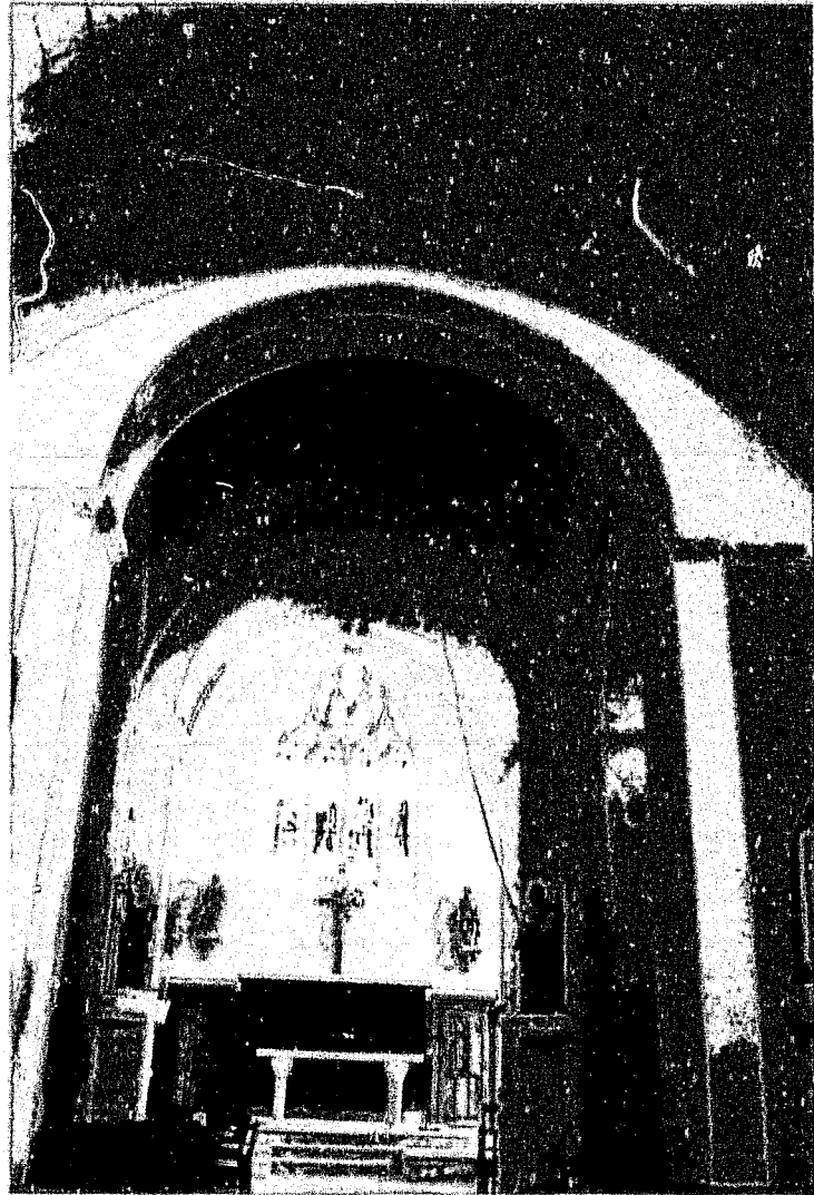
Fig. 10 : Semoussac. Travée sous clocher vue depuis la nef.
