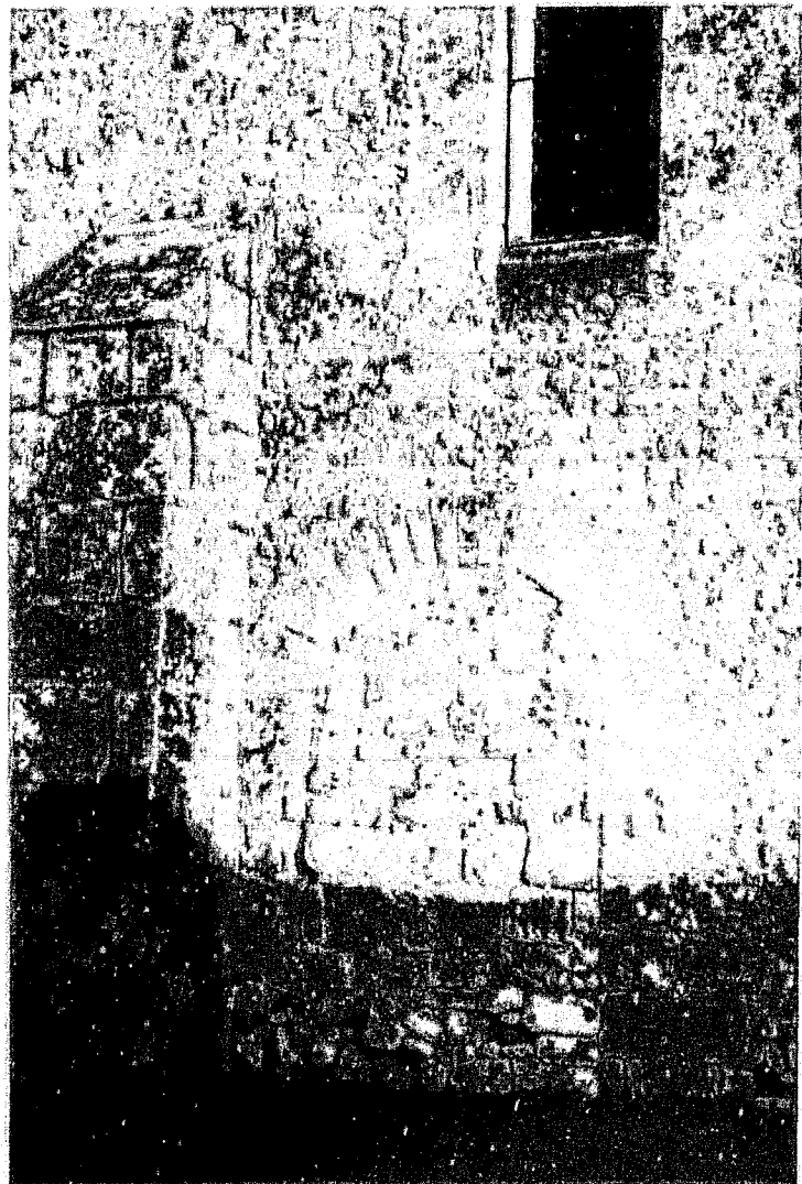
Fig. 3 : Dompierre-sur-Charente. Mur sud de la nef. Ancienne porte murée.
