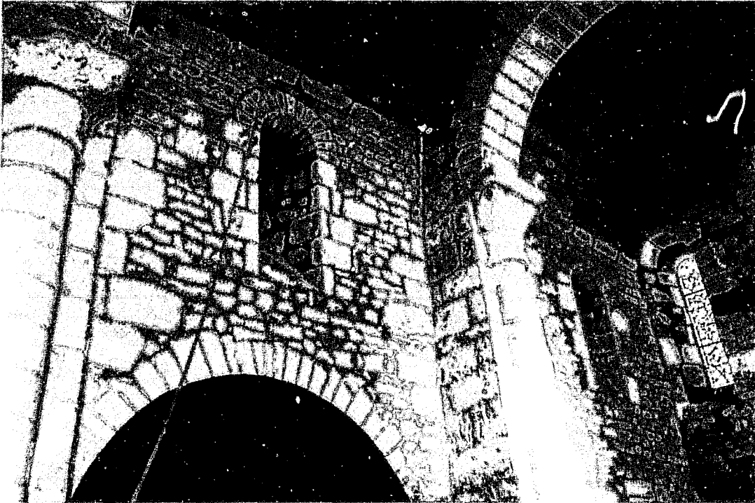
Fig. 6 : Les Pins. Mur nord des travées orientales. Fenêtres anciennes.
