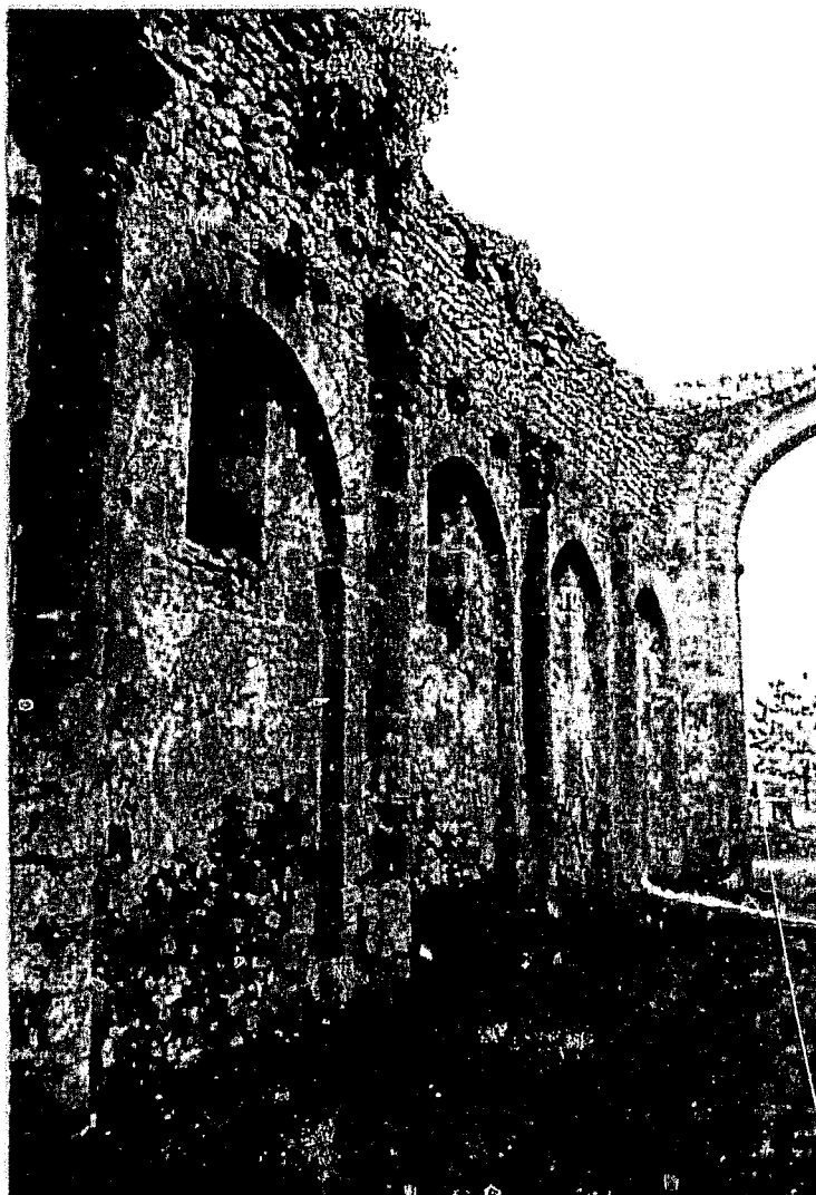
Fig. 10 : Châtelars Mur nord de la nef, Élévation intérieure vue vers l'est.
