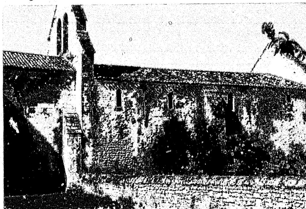
Fig. 3 : Sainte-Radegonde. Vue générale côté nord.
