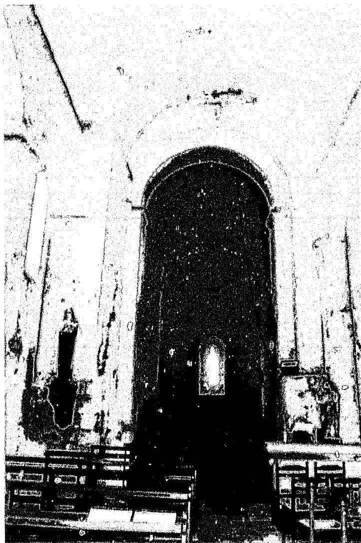
Fig. 12 : Nanclars. Vue générale intérieure vers l'est.
