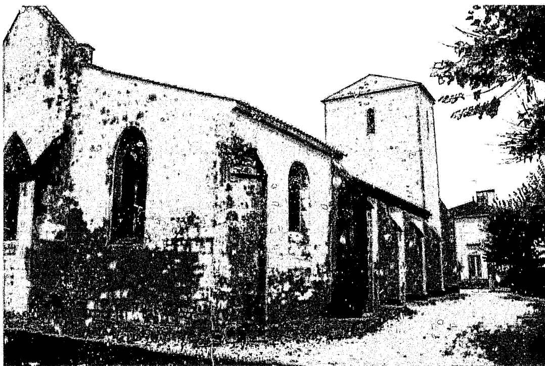
Fig. 2 : Saint-Laurent-de-la-Prée. Vue générale depuis le nord-est.
