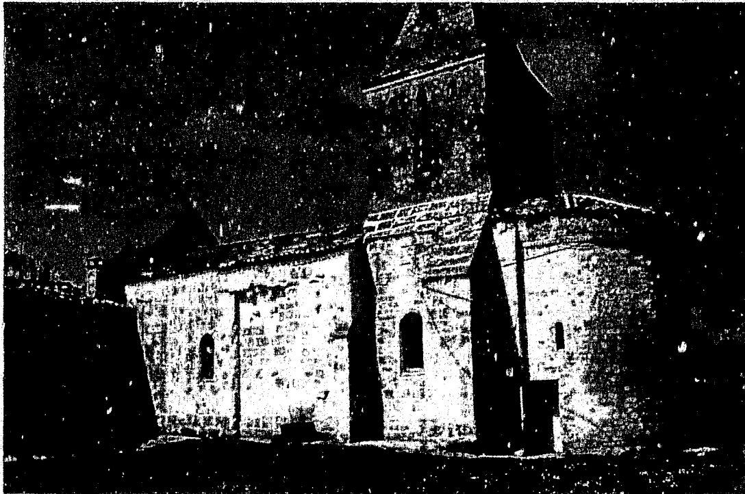
Fig. 2 : Antignac. Vue générale depuis le sud-est.
