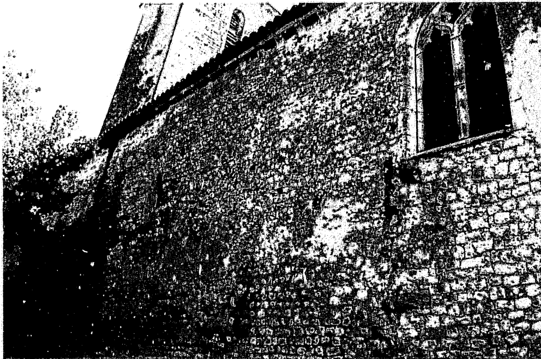
Fig. 3 : Petit-Niort. Mur nord de la nef, vu depuis le nord-ouest.
