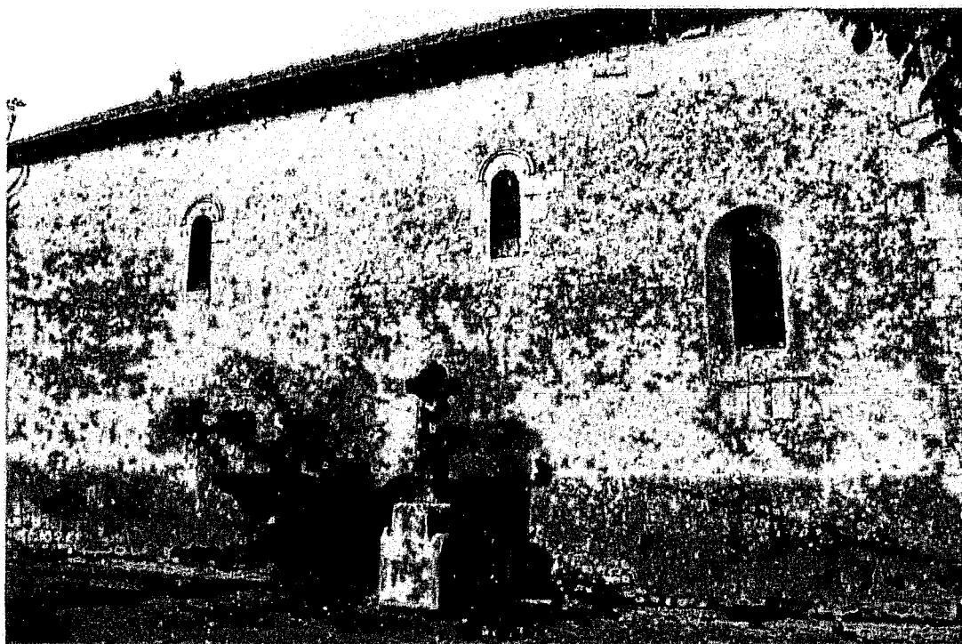
Fig. 4 : Givrezac. Mur sud de la nef.
