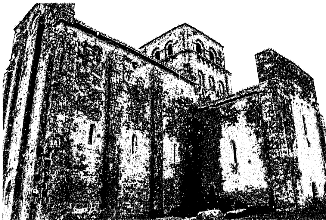
Fig. 4 : Nanclars. Vue générale depuis le sud-ouest.
