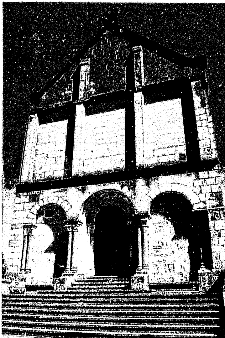
Fig. 8 : Puyperoux. Façade occidentale.
