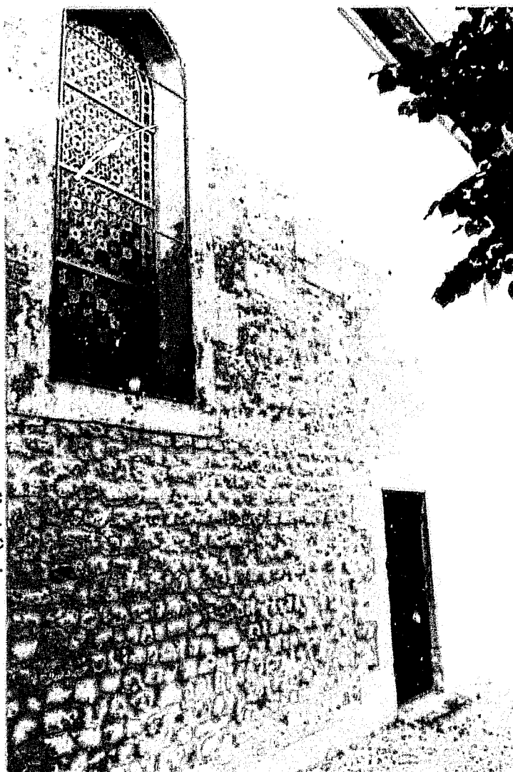
Fig. 3 : Courcoury. Mur sud de la nef avec fenêtre ancienne bouchée.
