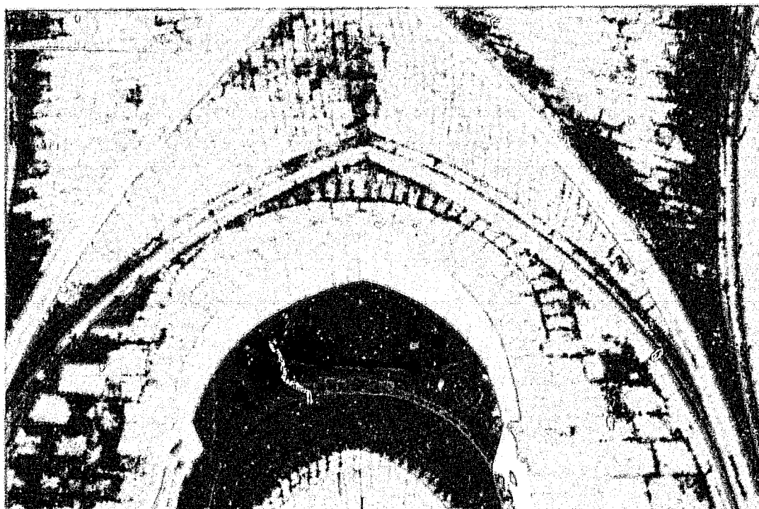
Fig. 13 : Saint-Martial-de-Mirambeau. Revers oriental de l'ancienne croisée du transept. Arc primitif et impostes à billettes.
