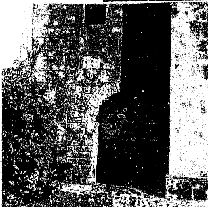
Fig. 7 : Thaims. Mur nord de la travée sous clocher. Arcade préromane.
