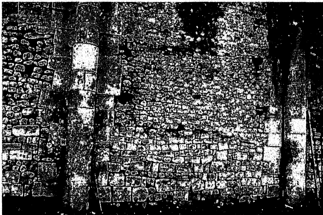
Fig. 15 : Bouteville. Mur gouttereau sud. Parement de moellons entre deux colonnes, et reprises de la partie inférieure.
