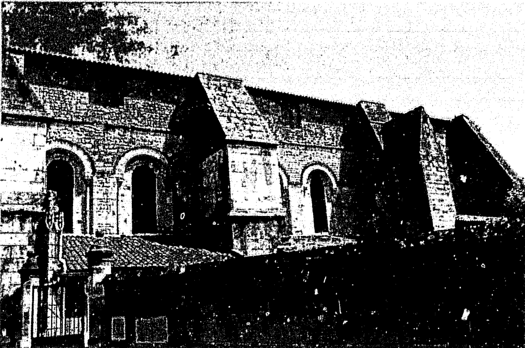
Fig. 5 : Barbezieux. Elévation sud. Partie hautes.
