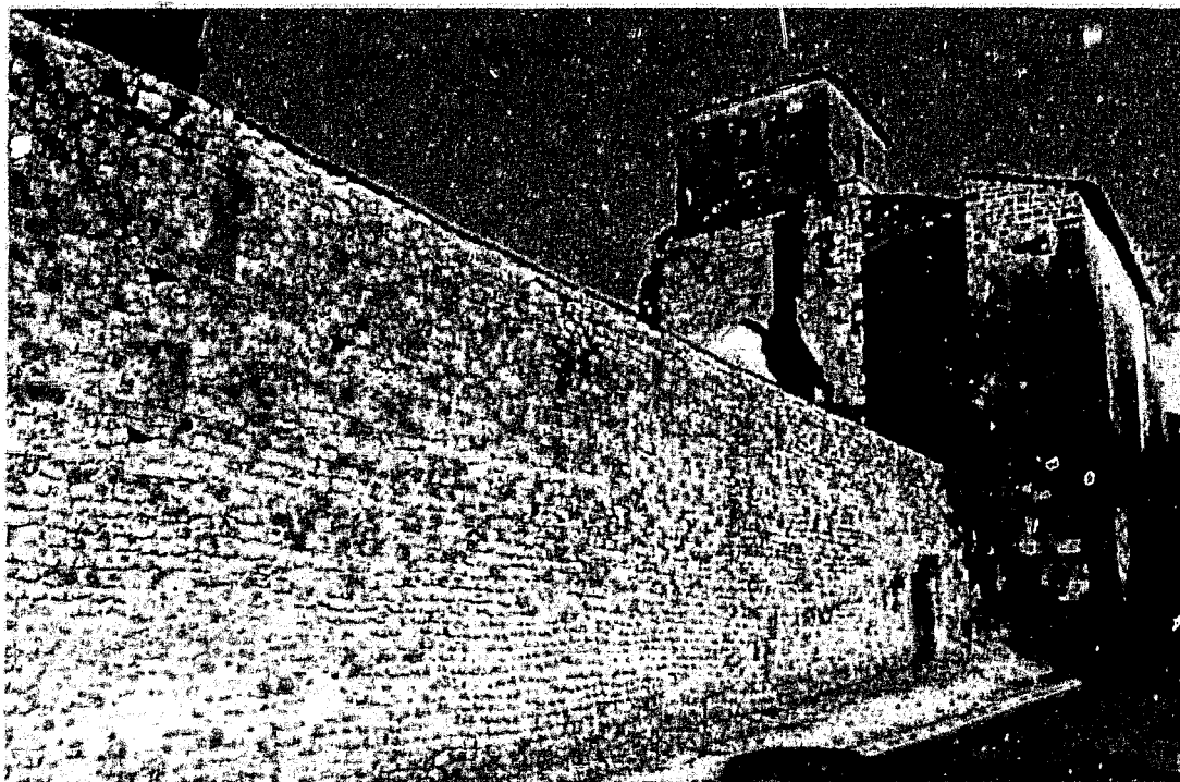
Fig. 10 : Bouteville. Ancien mur gouttereau sud de la nef, côté extérieur.
