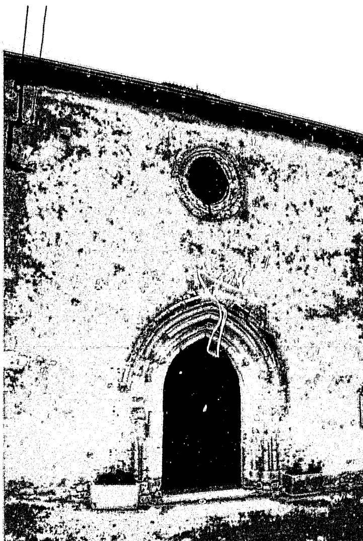
Fig. 3 : Saint-Denis-du-Pin. Façade occidentale.
