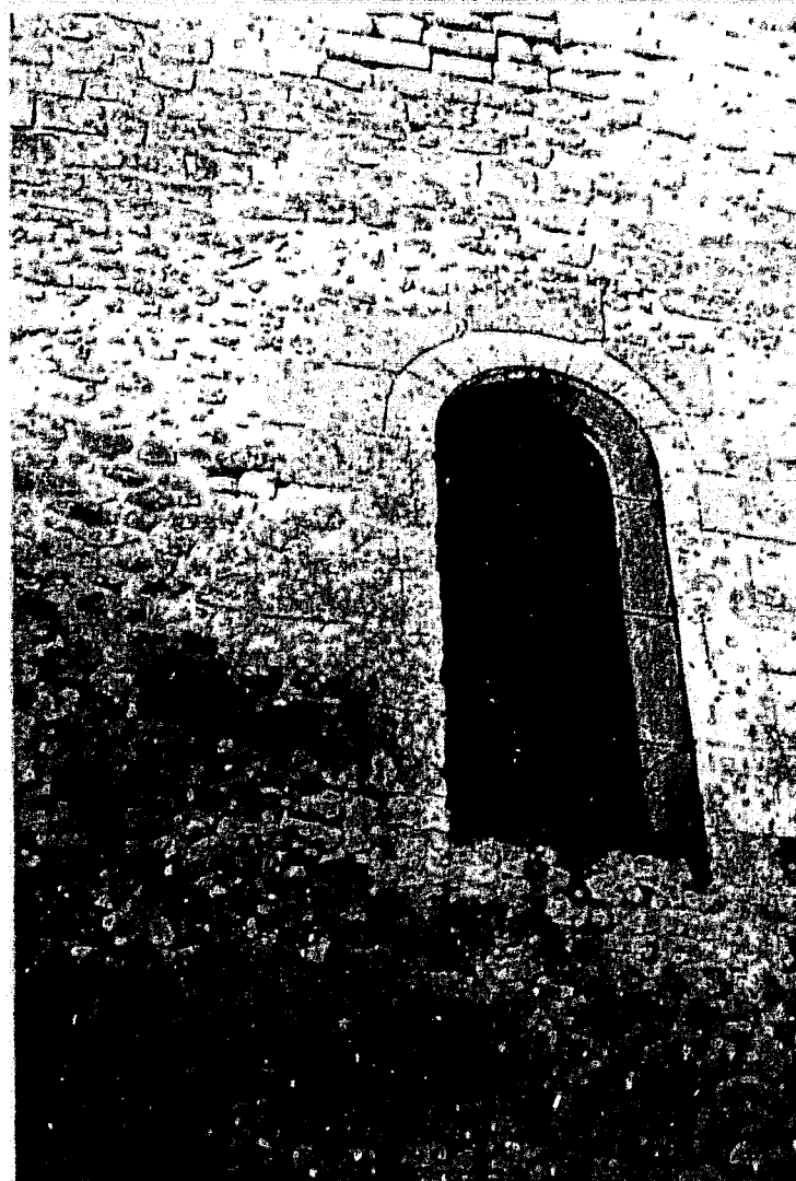
Fig. 16 : Bouteville. Fenêtre sud du transept.
