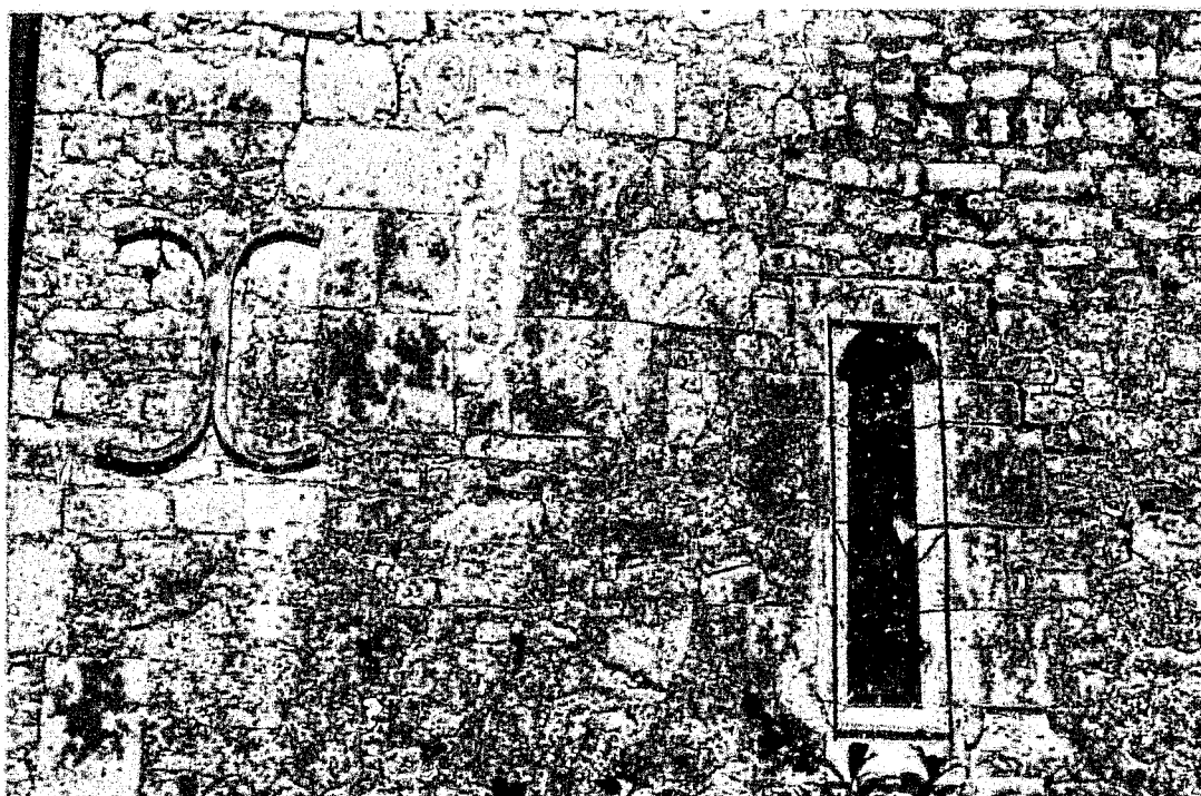
Fig. 9 : Saint-Sigismond-de- Clermont. Mur sud de la nef. Fenêtre ancienne et fenêtre ouverte au moment du voûtement.
