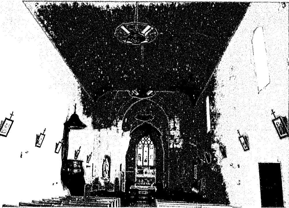
Fig. 10 : Saint-Martial-de-Mirambeau. Vue générale intérieure de la nef, vers l'est.
