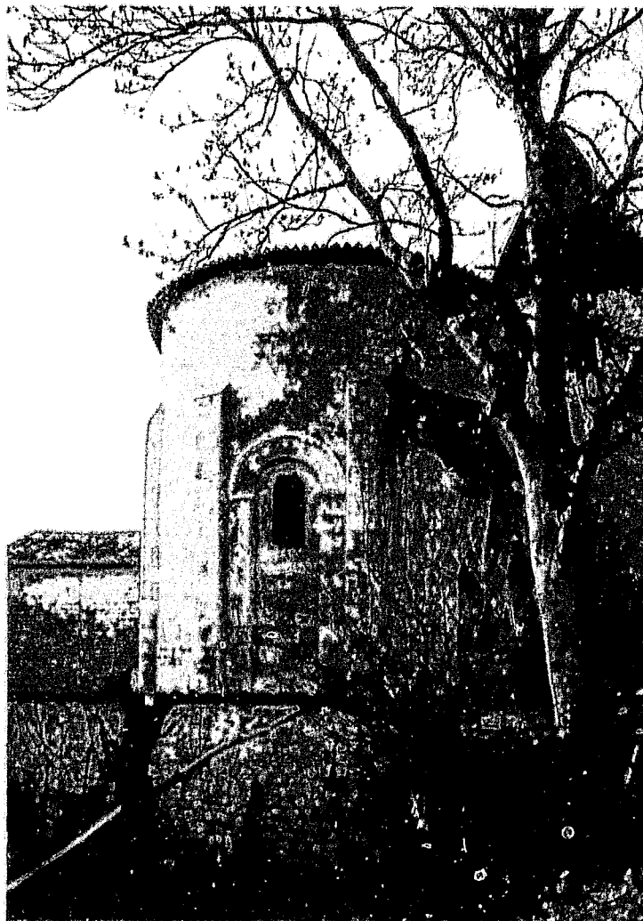
Fig. 8 : Fontenille. Chevet. Vue générale de l'abside.
