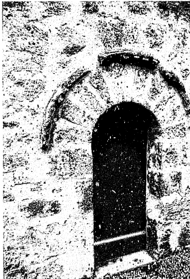
Fig. 7 : Saint-Laurent-de-la-Prée. Porte du mur sur l du bras de transept.
