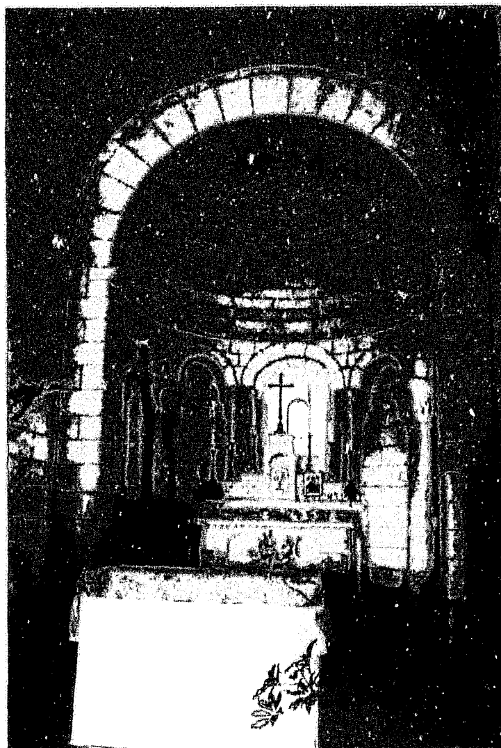
Fig. 11 : Cressac. Abside. Vue intérieure.
