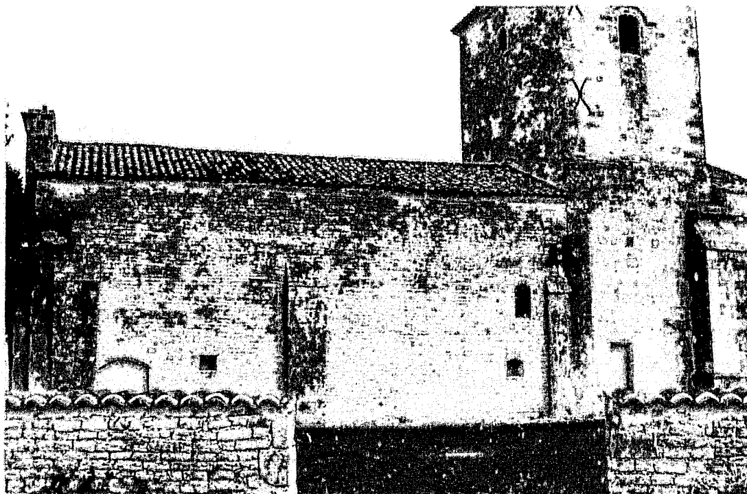
Fig. 3 : Bagnizeau. Mur sud de la nef.
