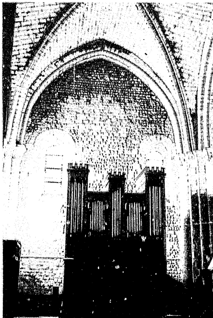
Fig. 27 : Saintes. Abbaye-aux-Dames. Bras nord du transept. Mur nord.
