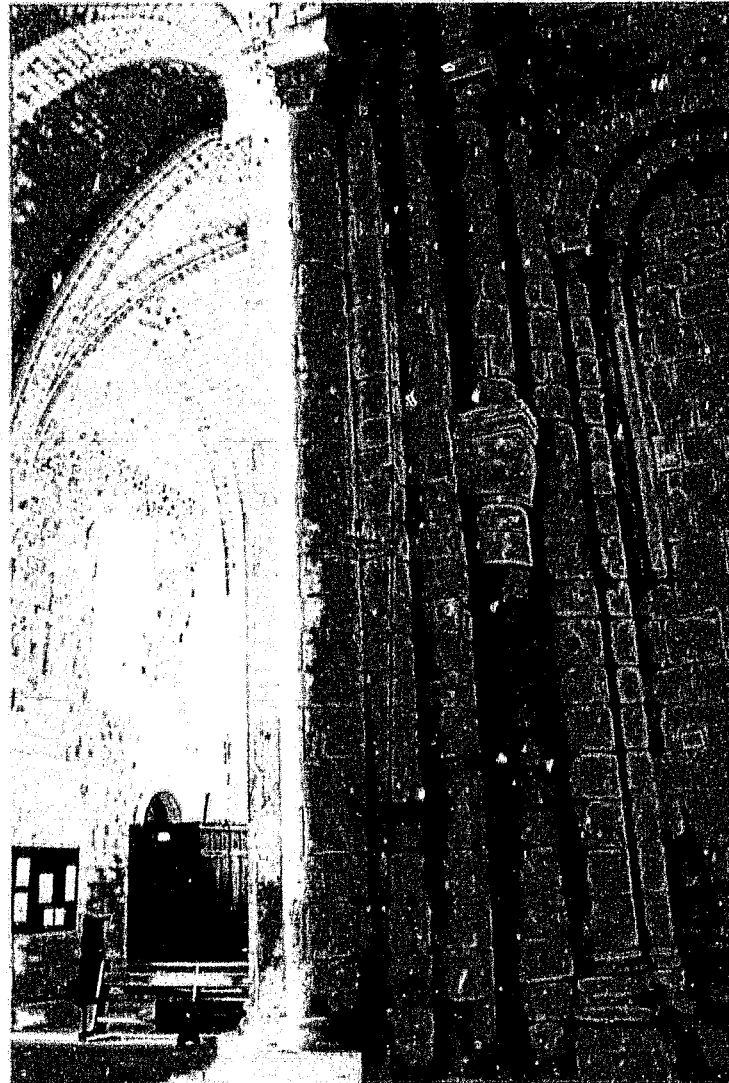
Fig. 33 : Saintes. Abbaye-aux-Dames. Revers oriental du pilier nord-est de la croisée et amorce de la travée de chœur. Au centre, ancienne colonne sud du pilier primitif.
