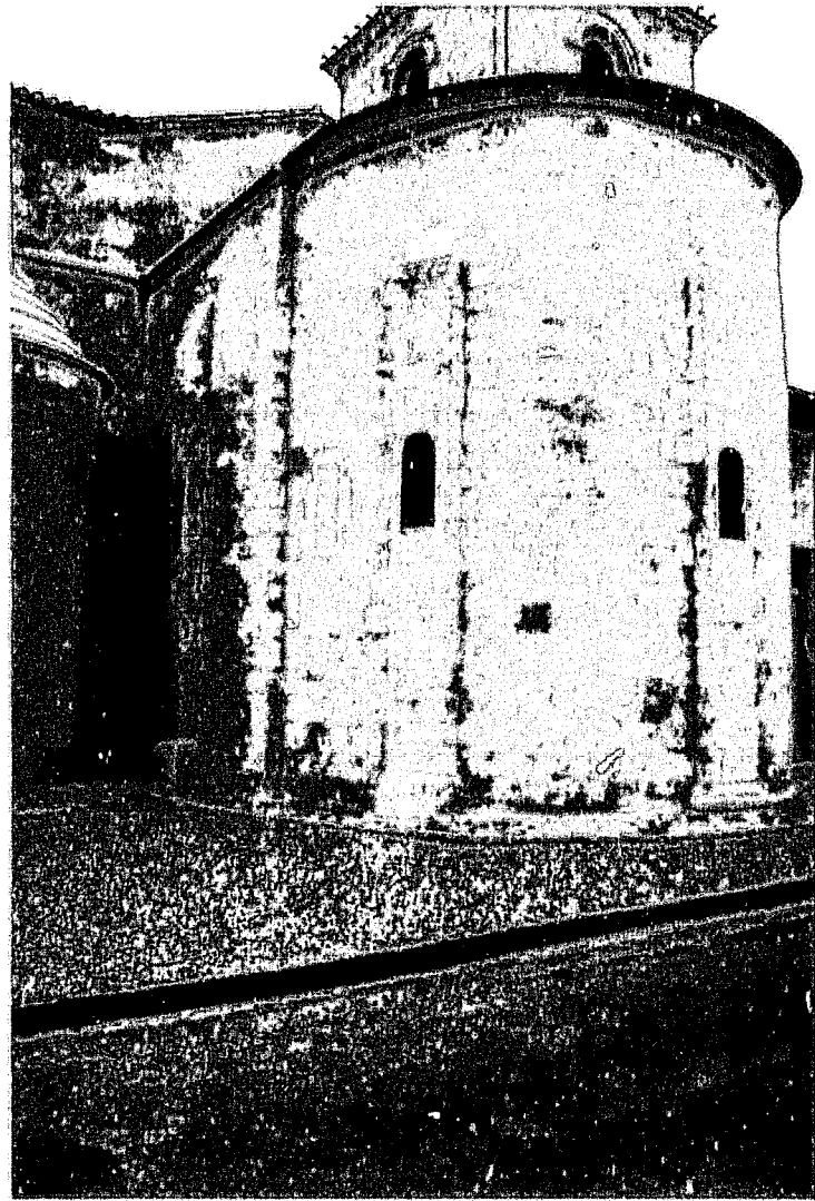
Fig. b : Cornemps (Gironde) Chevet avec fenêtre dans le contrefort.
