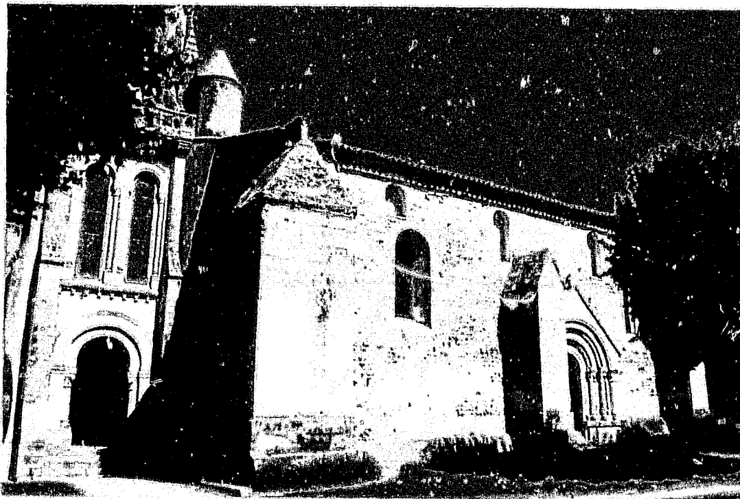
Fig. 2 : Saint-Dizant-du-Gua. Vue générale depuis le sud-ouest.
