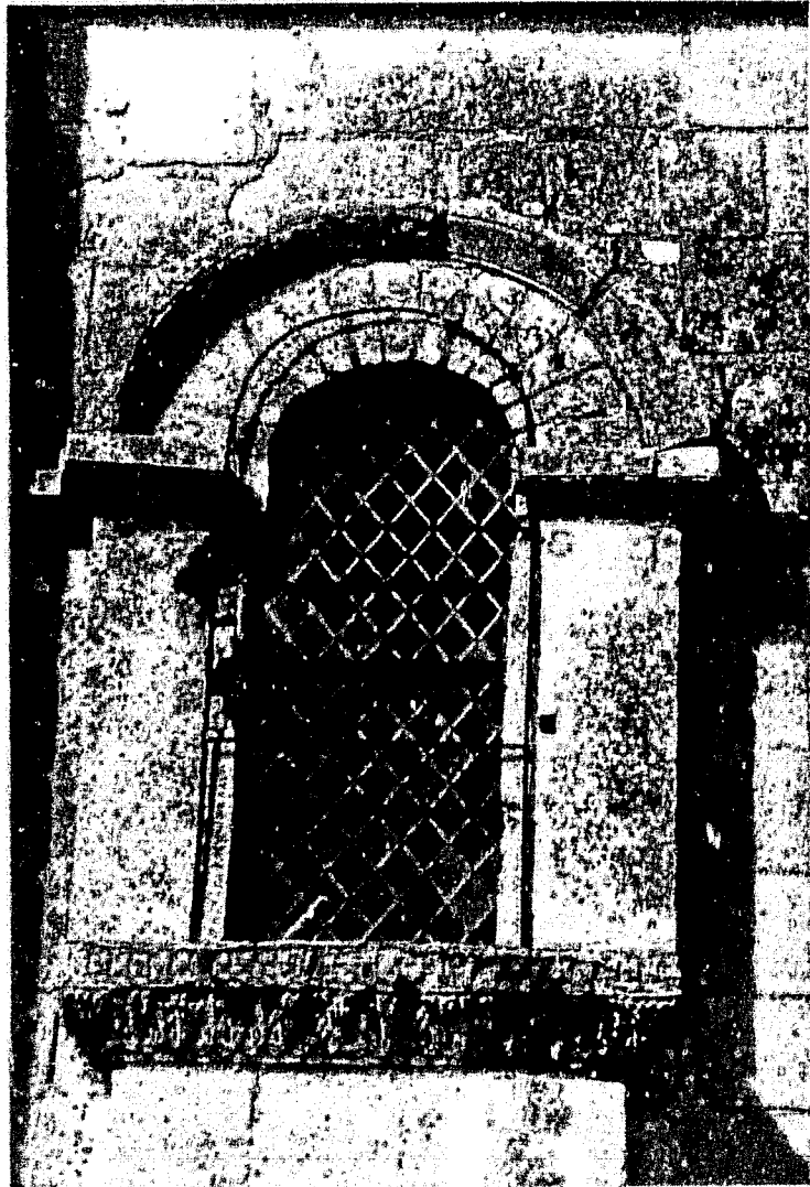
Fig. 24 : Bougneau. Fenêtre sud du chevet.
