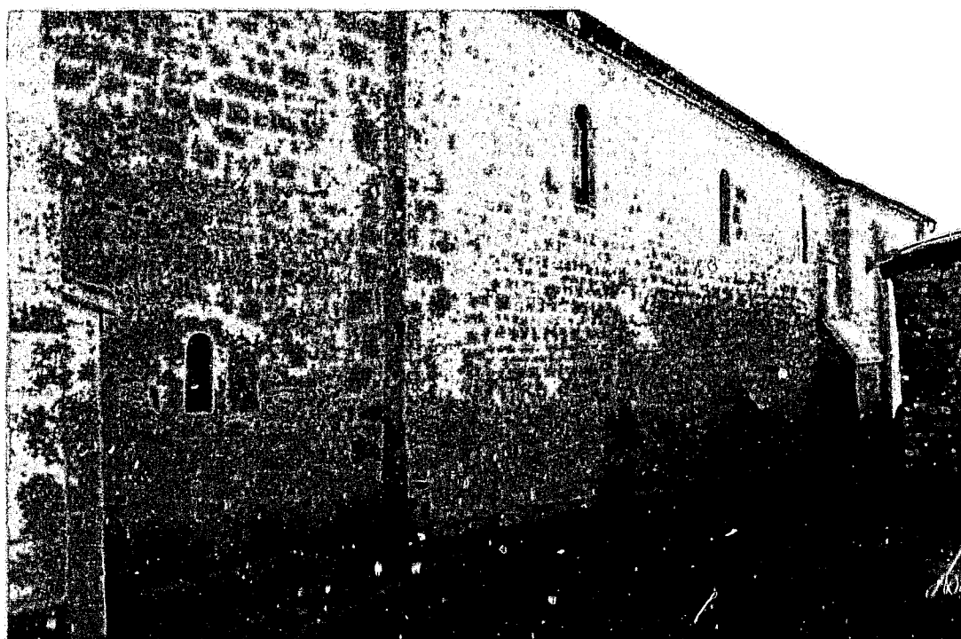
Fig. 6 : Brie-de-La Rochefoucauld. Mur nord de la nef. Extérieur.
