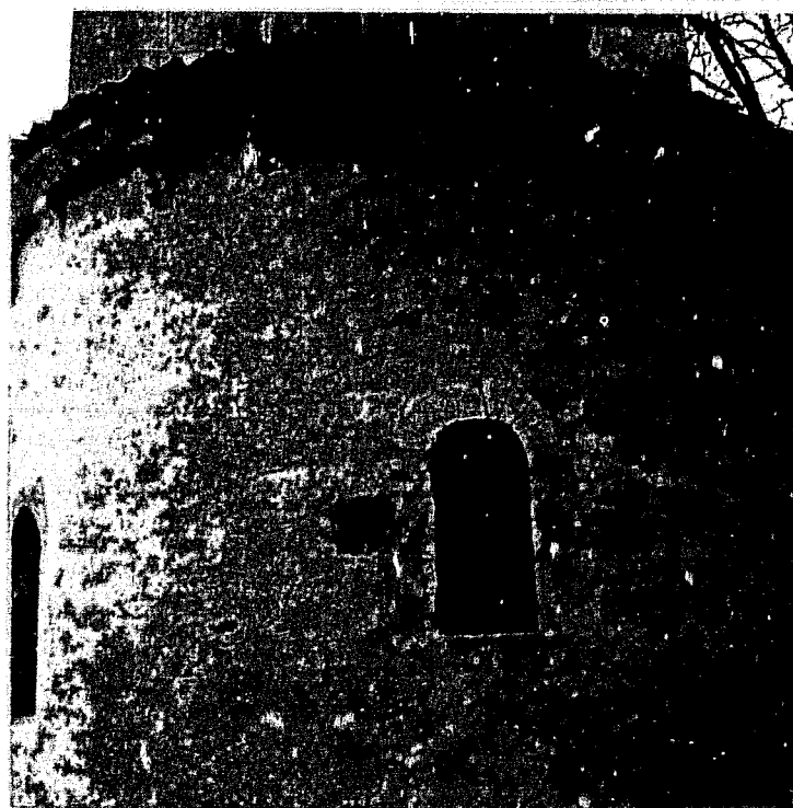
Fig. 9 : Fenêtre axiale du chevet. Vue extérieure.
