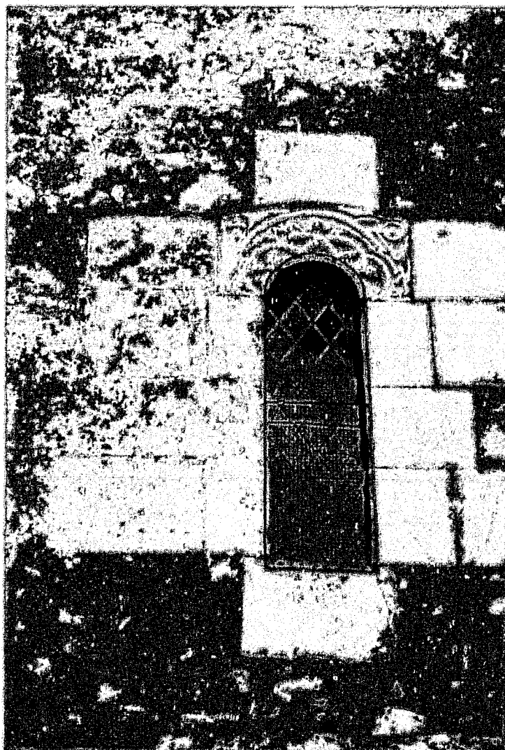
Fig. 5 : Sémillac. Fenêtre du mur nord de la nef.
