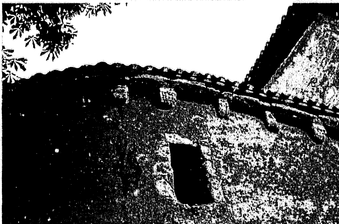
Fig. 5 : Brie-sous-Chalais. Détail des modillons de l'abside.
