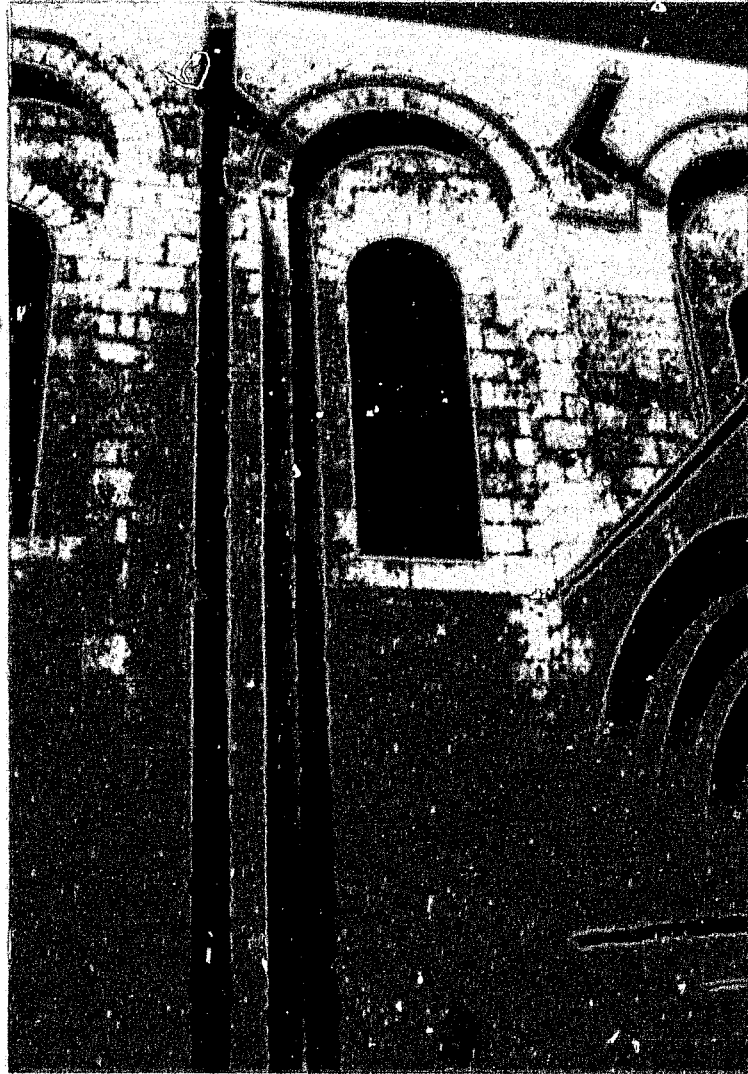
Fig. b : Saint-Michel- d'Entraygues (Charente). Usage tardif du petit appareil allongé.
