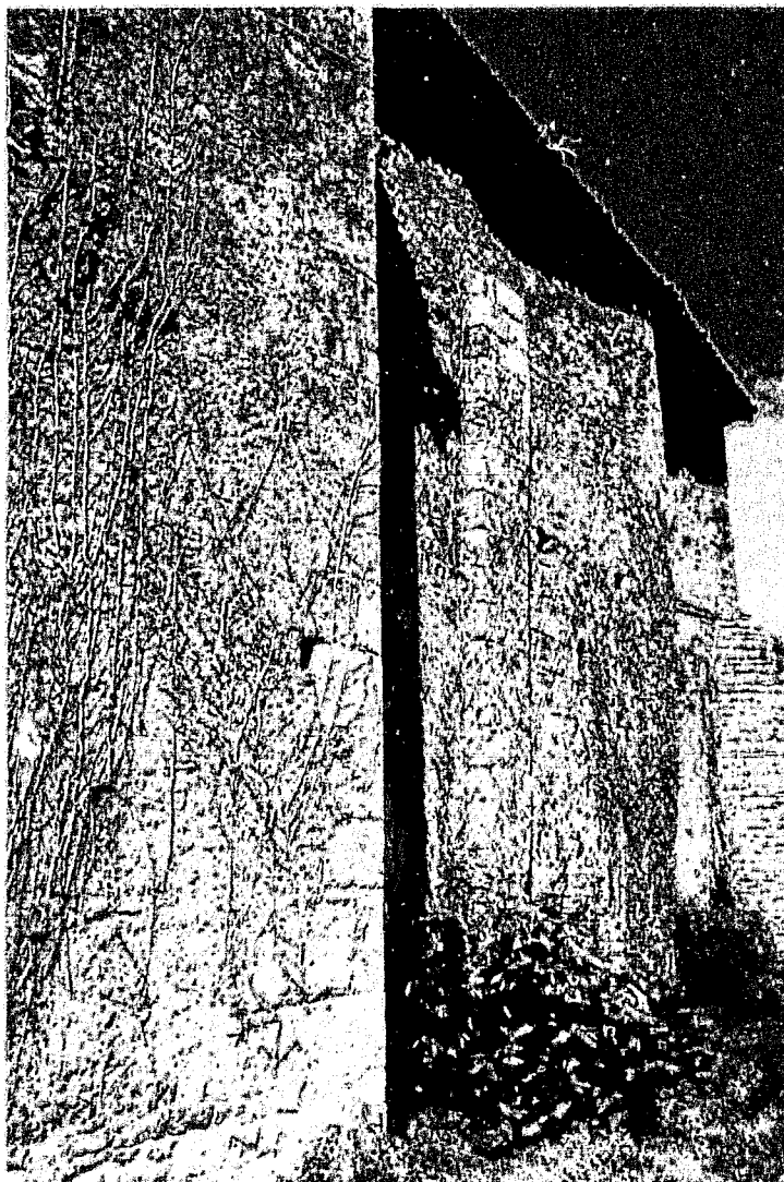
Fig. 4 : Négret. Mur sud.
