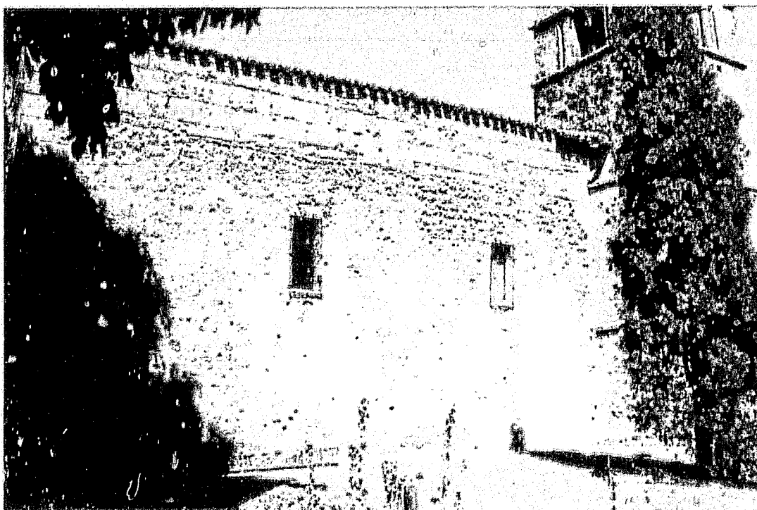
Fig. 5 : Saint-Trojan. Mur sud de la nef.
