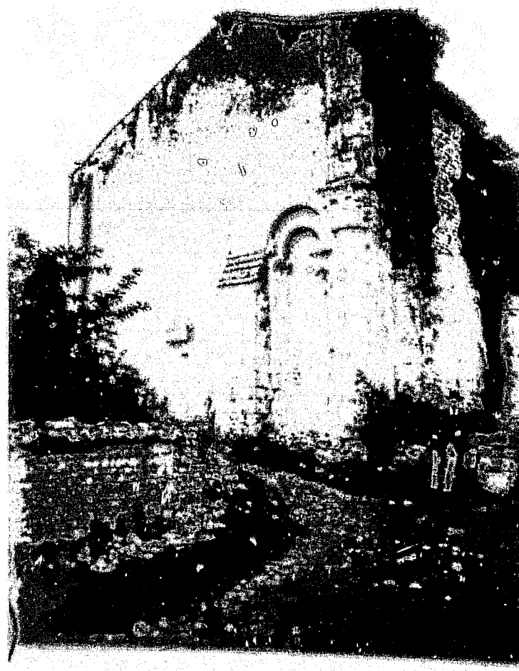
Fig. 4 : Montignac-sur-Charente. Vestiges du bras nord du transept vus du sud-ouest. Coll. A. Guérin-Boutaud. SAHC 4/169.2.
