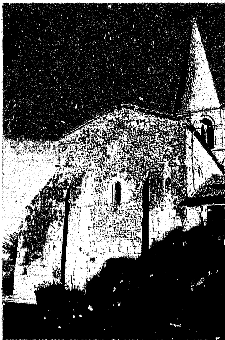
Fig. 2 : Saint-Estèphe. Façade occidentale.
