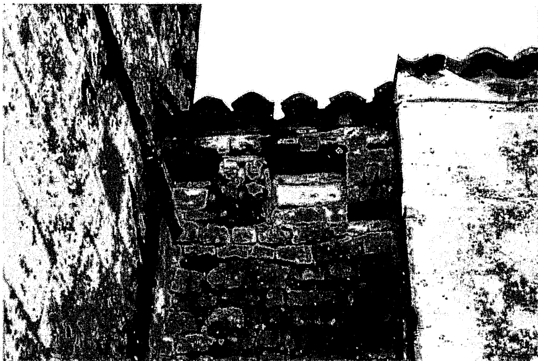
Fig. 14 : Saint-Trojan. Travée droite de choeur. Modillons et corniche du mur sud.
