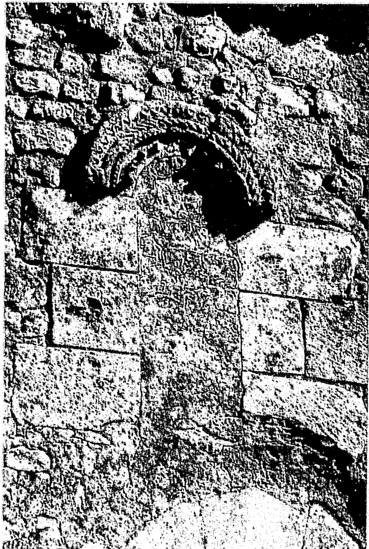
Fig. 5 : Saint-Germain-du-Seudre. Ancienne fenêtre du mur sud de la nef.
