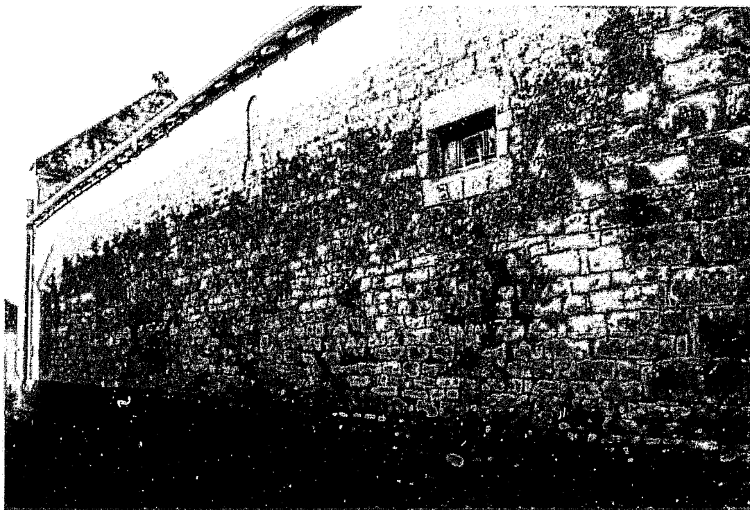
Fig. 2 : Couture. Mur sud de la nef vu vers l'ouest.
