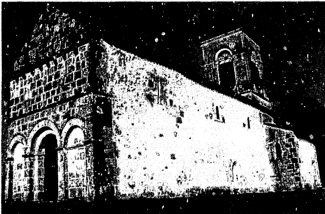
Fig. 5 : Chavenat. Vue générale depuis le sud-ouest.
