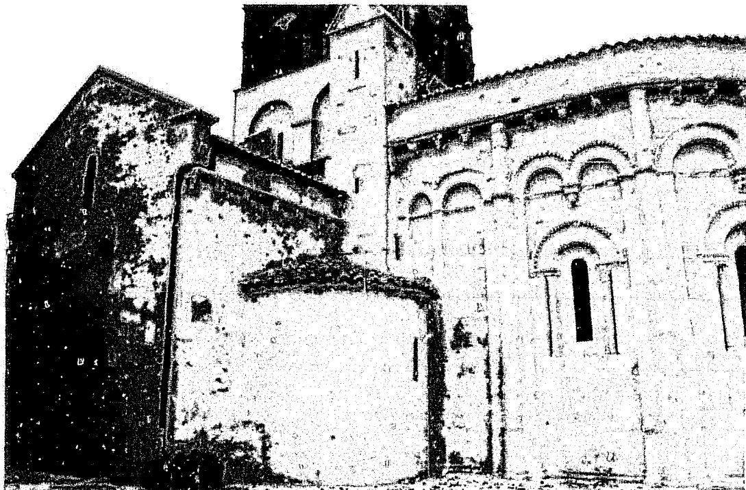
Fig. 7 : Pérignac. Bras sud du transept et absidiole.
