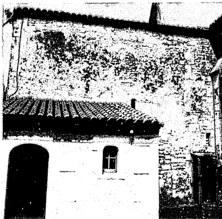
Fig. 5 : Saint-Dizant-du-Gua. Chapelle (ou bras de transept) sud. Face mériidionale.
