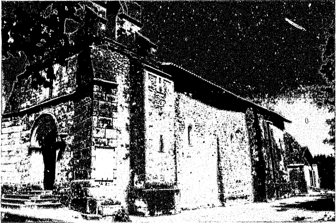
Fig. 2 : Saint-Cybard-de-Montmoreau. Vue générale depuis le sud-ouest.
