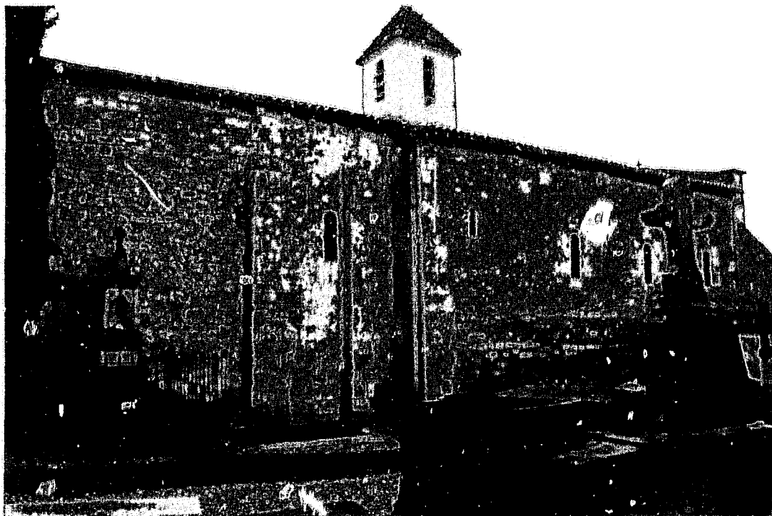
Fig. 4 : Sémillac. Ensemble du mur nord vu depuis le nord-est.
