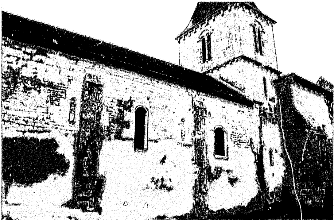
Fig. 5 : Saint-Hilaire-du-Bois. Mur sud de la nef et travée sous clocher.
