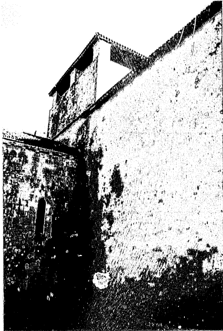
Fig. 6 : Rivières. Mur nord de la nef et bras nord du transept.
