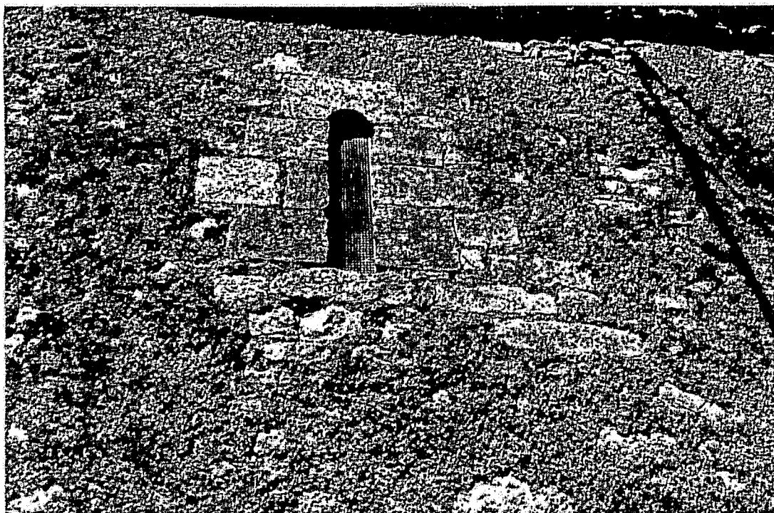
Fig. 4 : Cherbonnières. Fenêtre du mur sud.
