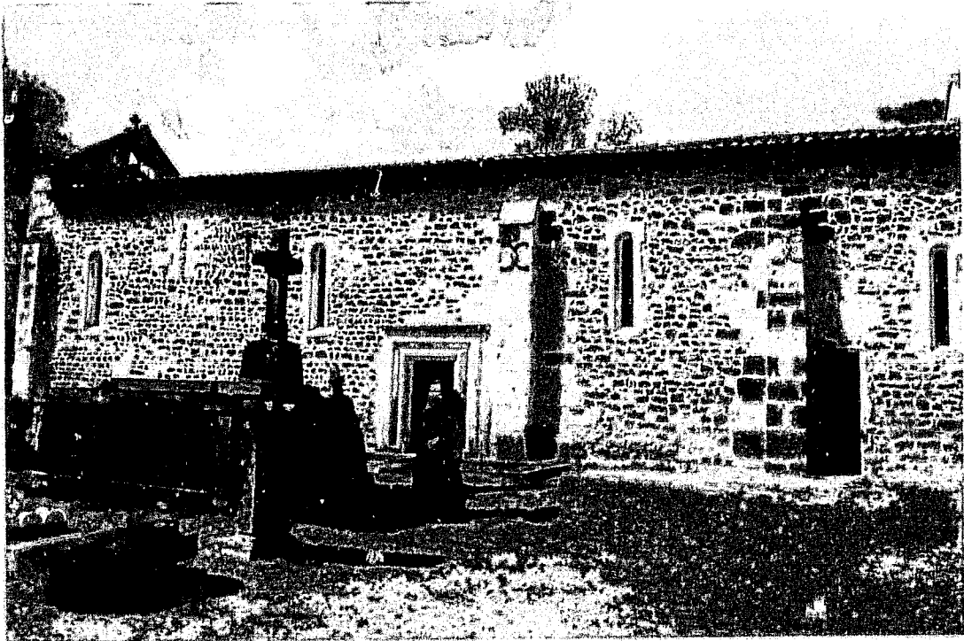
Fig. 2 : Lugéras. Vue générale côté sud.
