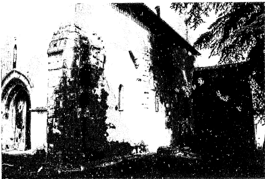
Fig. 3 : Nonac. Mur sud de la nef.
