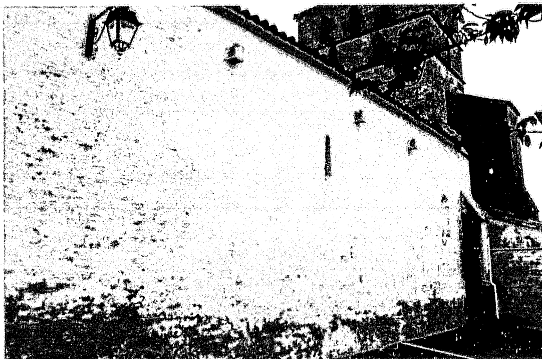
Fig. 3 : Réparsac. Mur sud de la nef.
