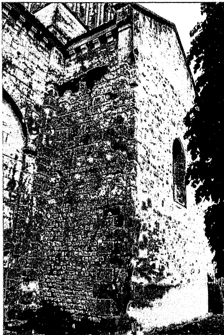
Fig. 4 : Passirac. Bras sud du transept vu depuis le sud-ouest.
