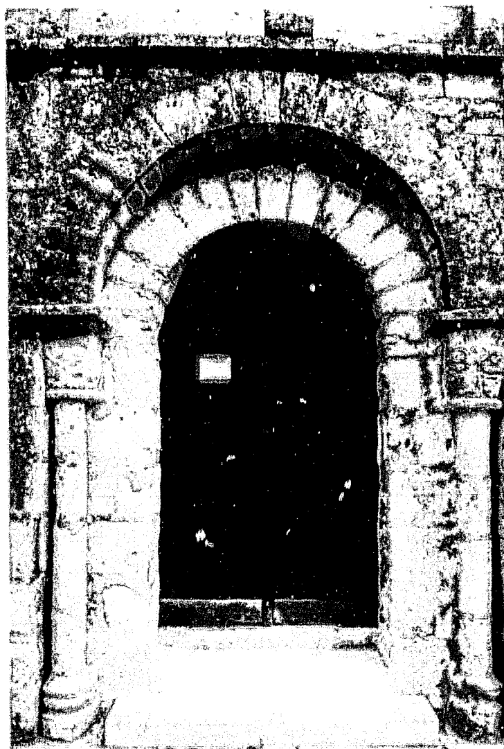
Fig. 14 : Coulgens. Portail occidental.
