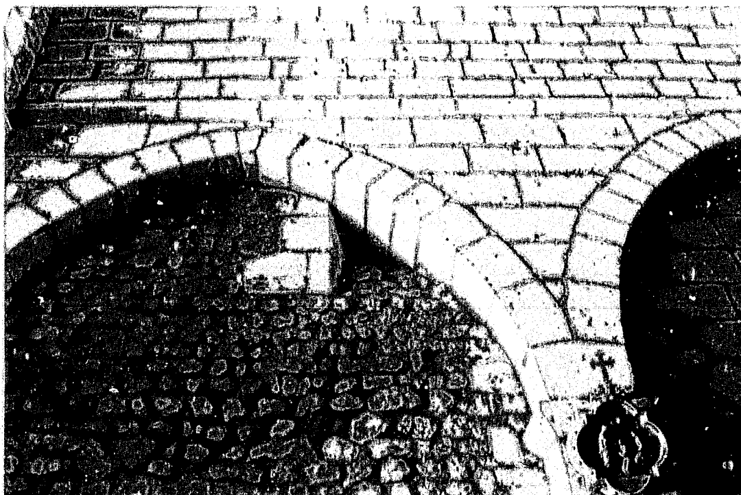
Fig. 8 : Saint-Estèphe. Mur nord de la nef. Trace de l'ébrasement intérieur d'une ancienne fenêtre.
