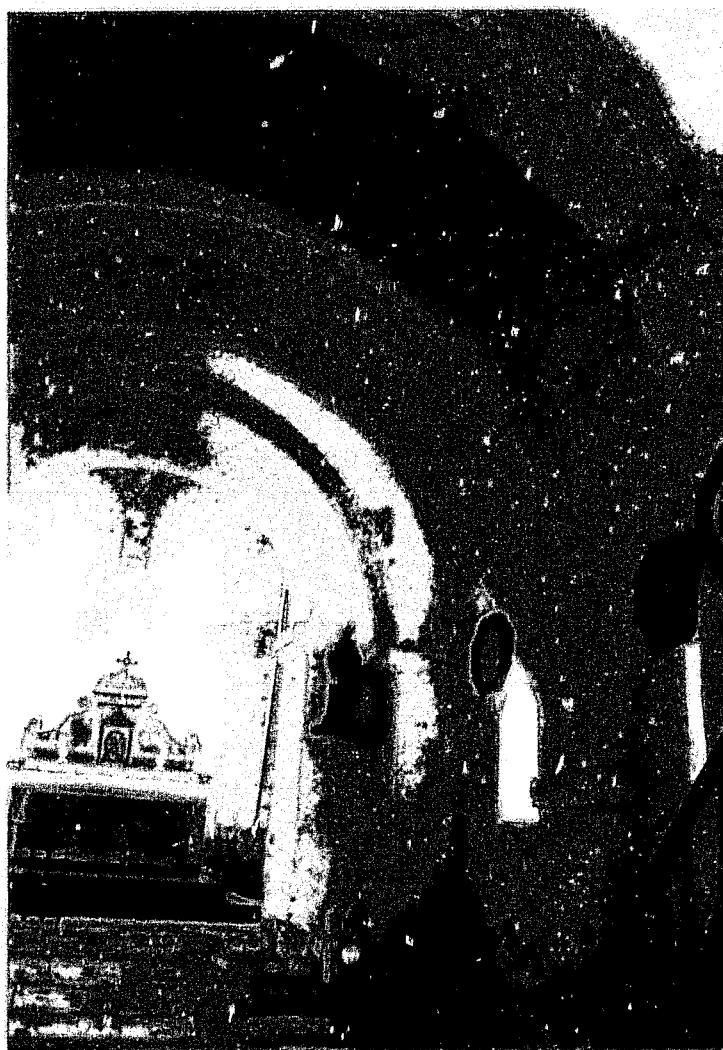
Fig. 11 : Poullignac. Travée sous clocher. Mur sud vu depuis la nef.
