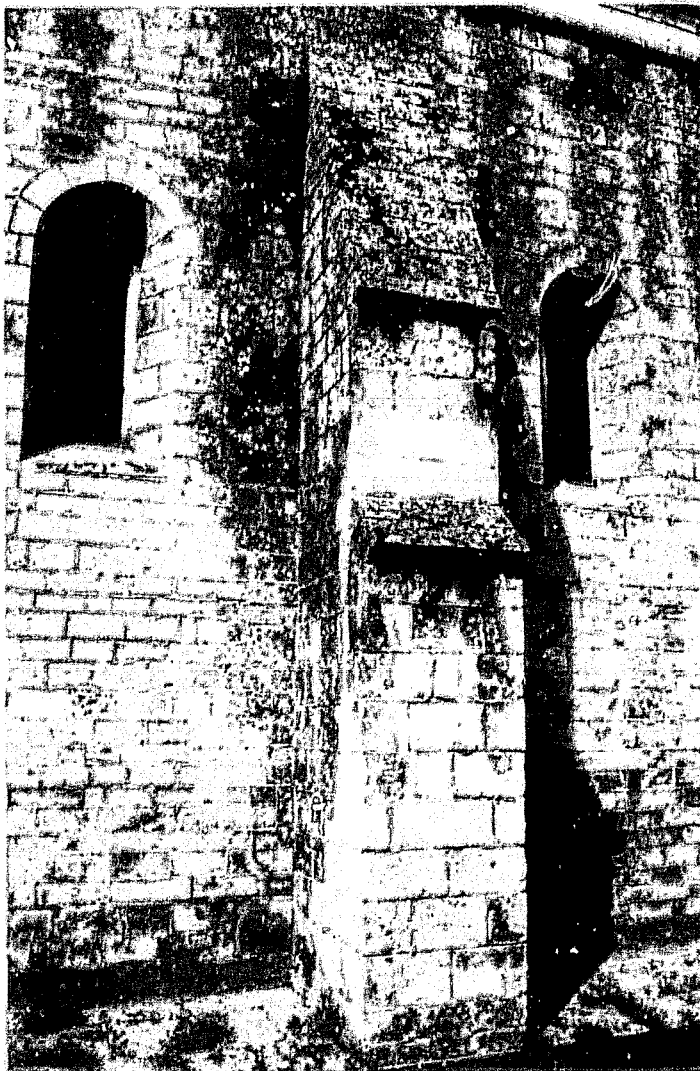
Fig. 3 : Mouthiers-sur-Boême. Parement extérieur du mur nord de la nef. Petit appareil allongé.
