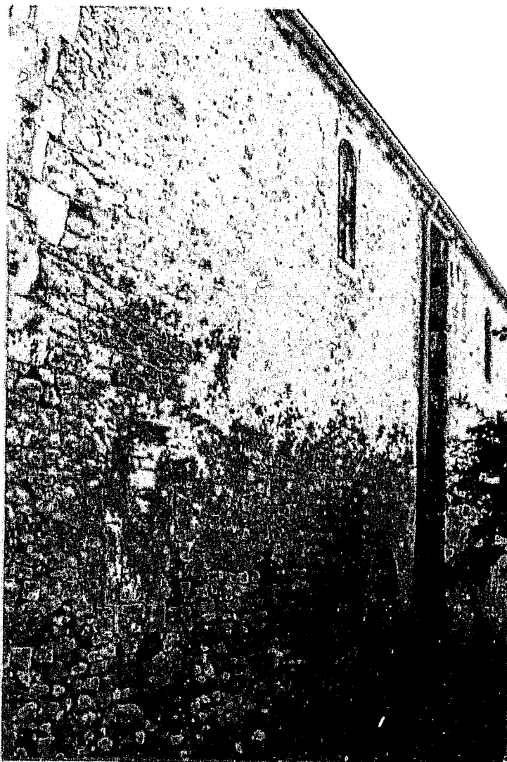
Fig. 6 : Semoussac. Mur nord de la nef vu depuis le nord-est.
