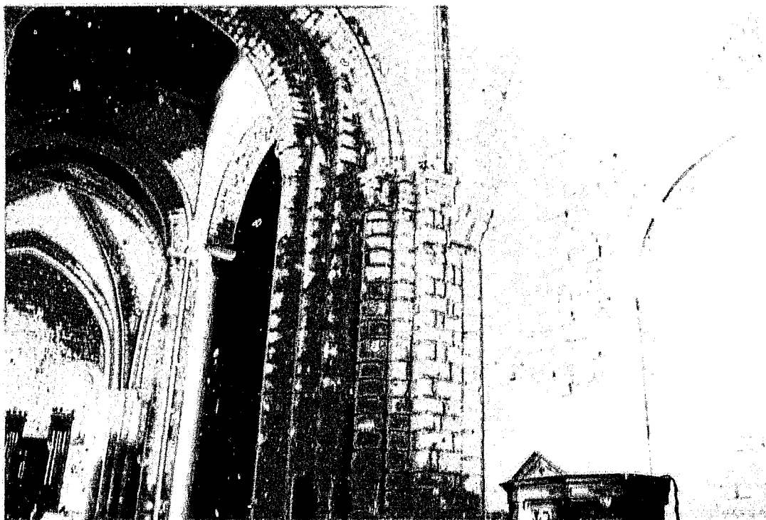
Fig. 31 : Saintes. Abbaye-aux-Dames. Pilier sud-est de la croisée vu depuis le bras sud du transept. Au centre, colonne primitive rehaussée.
