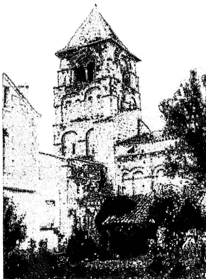
Fig. 4 : Pérignac. Photographie du clocher avant sa reconstruction. Cliché publié par Jean George.
