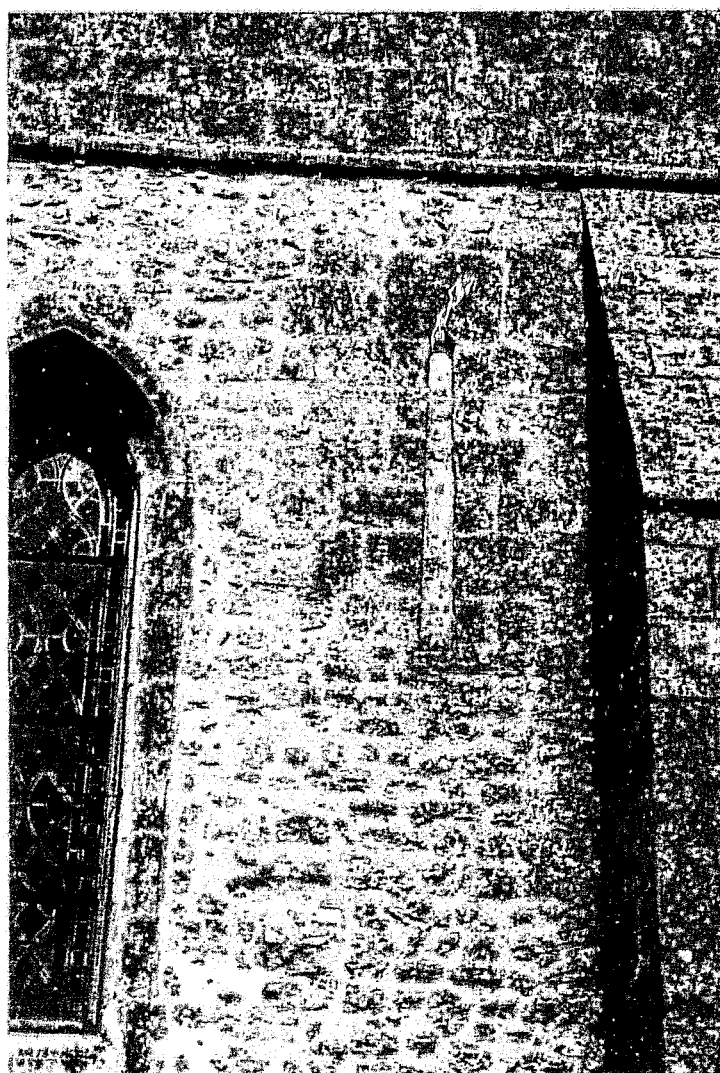
Fig. 3 : Montpellier-de-Médillan. Ancienne fenêtre du mur sud de la nef.
