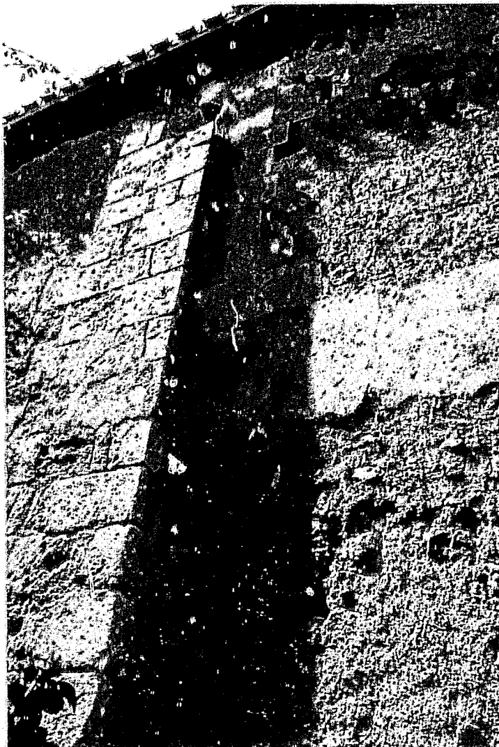
Fig. 5 : La Tâche. Contrefort du mur sud de la nef.
