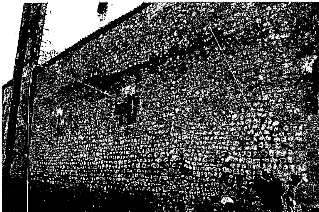
Fig. 3 : La Chapelle. Elévation extérieure nord de la nef.
