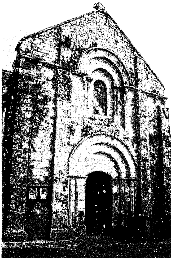
Fig. 6 : Couture. Façade occidentale.
