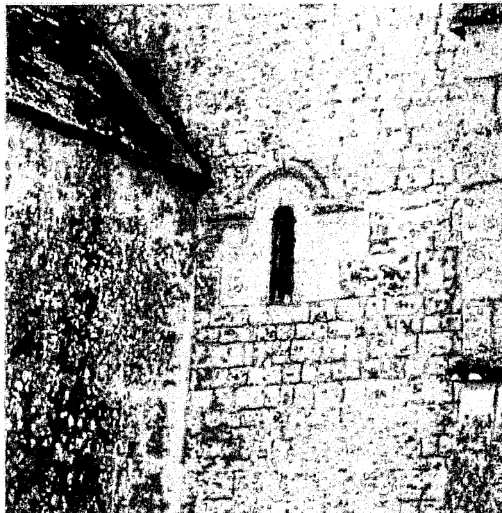
Fig. 7 : Lagarde-sur-le-Né. Fenêtre sud de la travée sous clocher.
