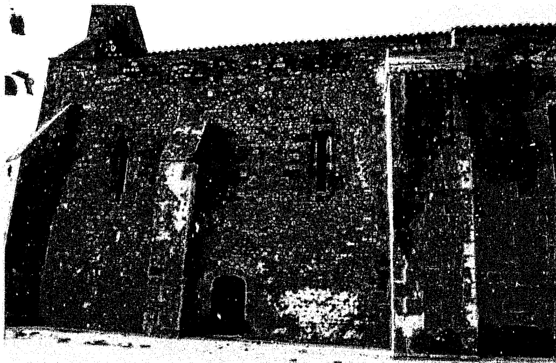
Fig. 10 : Meux. Mur sud de la nef.
