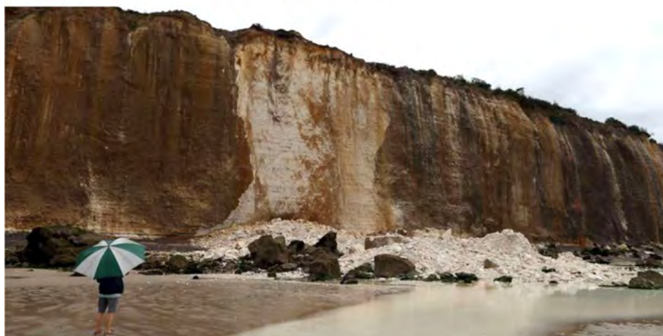
Figure 3.19 : Accident mortel le 14/08/2015 à Varengeville-sur-Mer où un pêcheur à pied est retrouvé sous un éboulement ( Sud-Ouest , agence France-Presse C. Triballeau)
