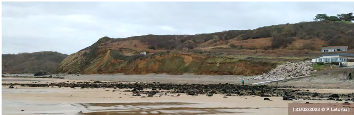
Photographie 4.2 : Site des Vallées à Pléneuf-Val-André (Côtes-d'Armor)
