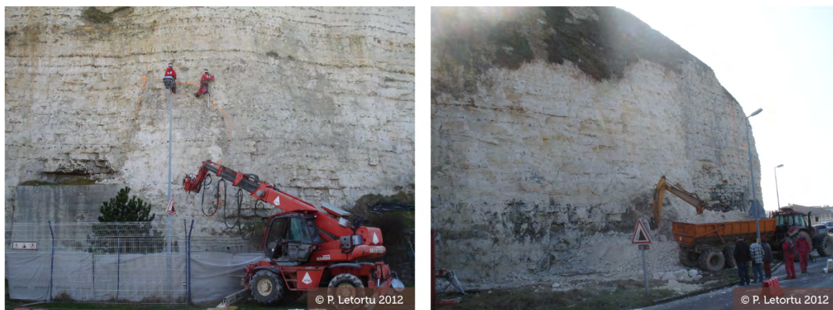
Photographie 3.1 : Travaux de sécurisation du site de Dieppe 1 O (à gauche) et Dieppe 2 N (à droite)
