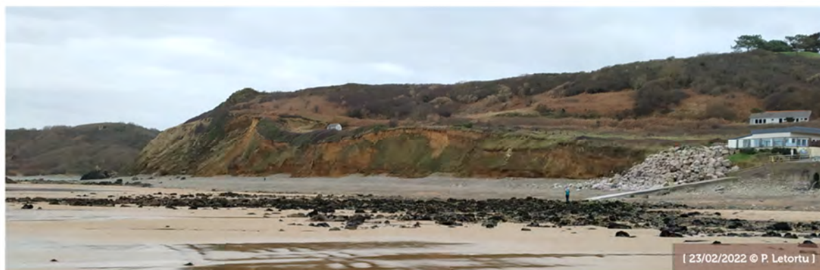
Photographie 4.2 : Site des Vallées à Pléneuf-Val-André (Côtes-d'Armor)
