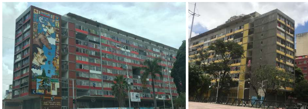
Image 103. Bâtiments GMVV Avenue Bolívar © yww 2019
