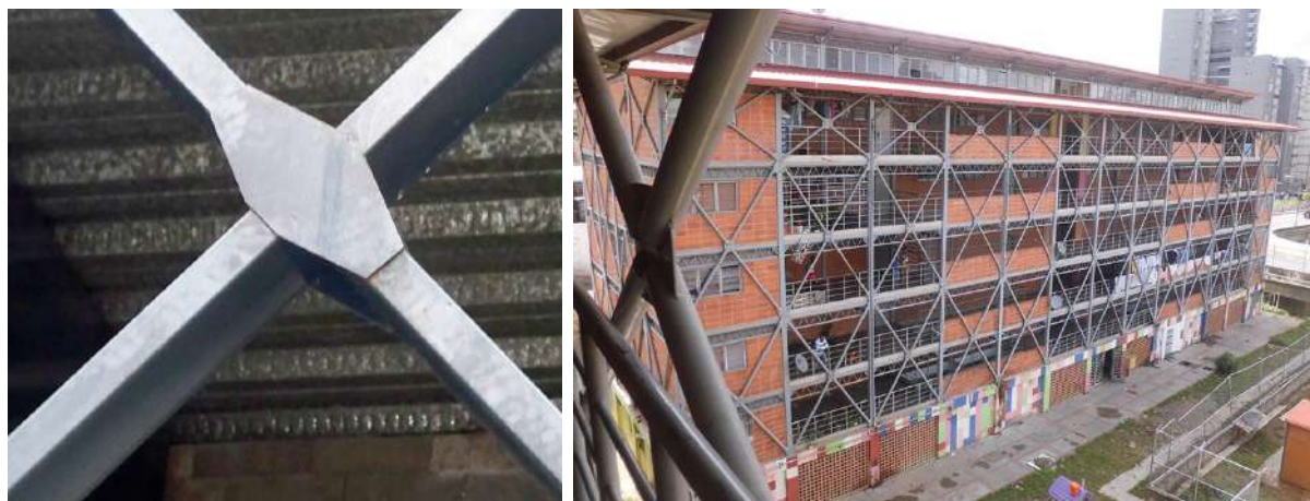
Image 99. à gauche poutres « Cruz de San Andrés » GMVV le panthéon, exemple « Cruz de San Andrés ». © D.S.
