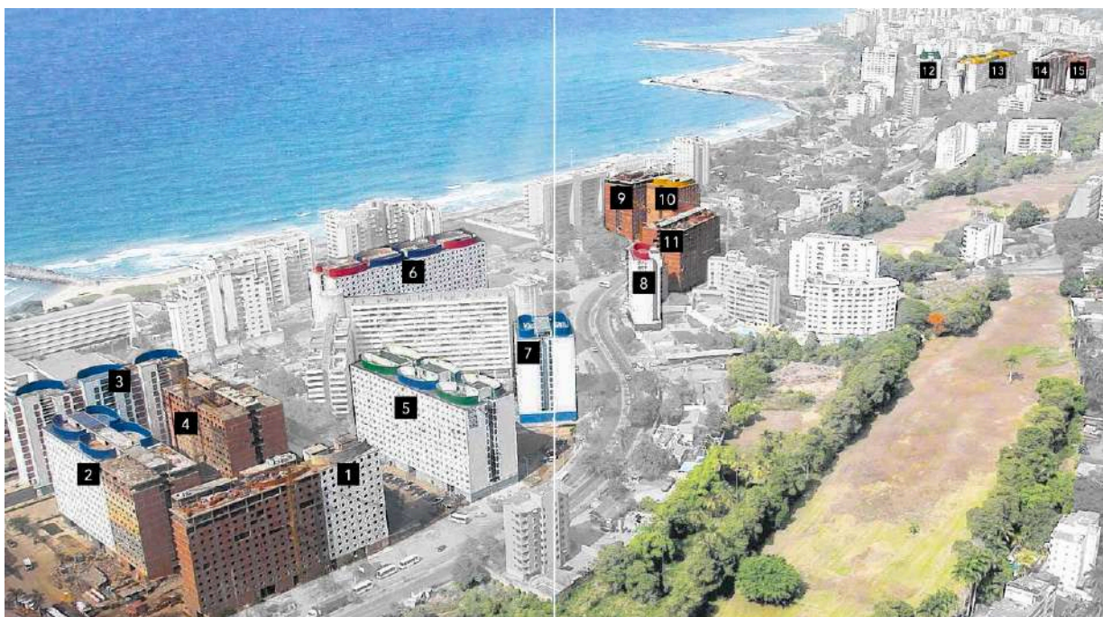
Image 93. Bâtiment 1 : 114 appartements, B2 : 294 appartements, B3 : 144 appartements, B4 : 294 appartements, B5 : 294 appartements, B6 : 392 appartements, B7 : 96 appartements, B8 : 48 appartements, B9 : 144 appartements, B10 : 96 appartements, B11 : 193 appartements, B12 : 192 appartements, B13 : 420 appartements, B14 : 144 appartements, B15 : 96 appartements. Un total de 3061 logements dans cette vue aérienne. © Ciudad Caracas. Correo del Orinoco, 2013. Intervention par l'auteur.
