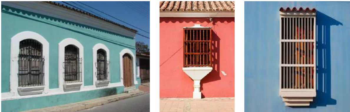
Image 152. Exemples de fenêtres de l'architecture coloniale @ Gasparini
