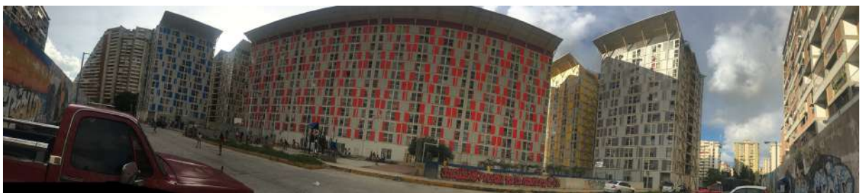
Image 118. Bâtiments GMVV, Montalbán, Caracas, © yww 2017
