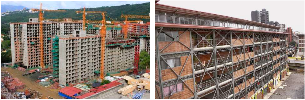
Image 85. À gauche Ciudad Tiuna. Murs porteurs en béton. À droite Cadres en acier Galvanisé. El panteón. Ccs. ©MINVHI et Fundacaracas
