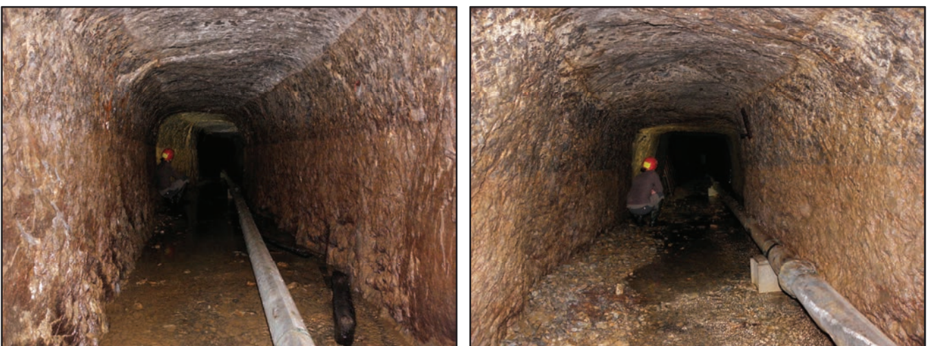
Fig. 190 : galerie de la Canal, tronçon à section quadrangulaire aux angles plus ou moins arrondis.
