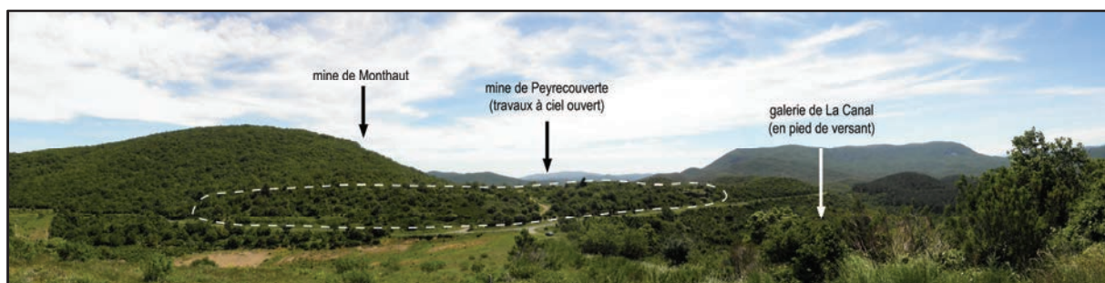
Fig. 183 : mine de Peyrecouverte, vue d'ensemble depuis le nord-ouest.
