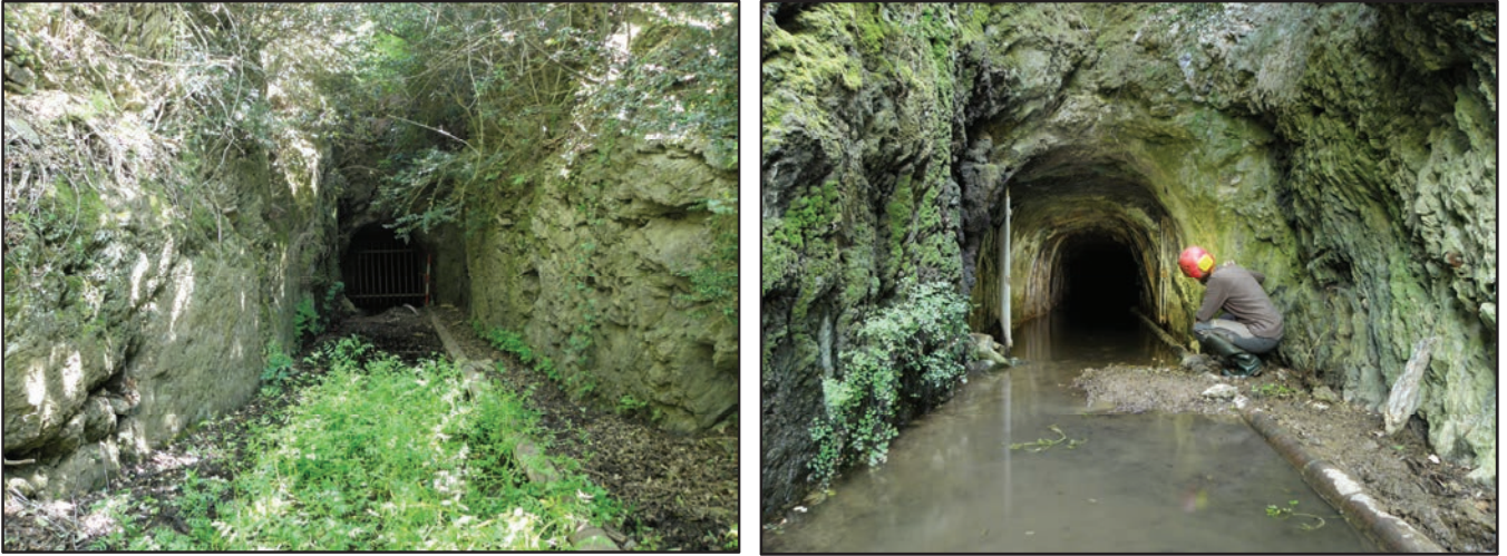
Fig. 188 : galerie de La Canal, vue de la tranchée d'accès creusée à l'outil (à g.) et de l'entrée de la galerie.
