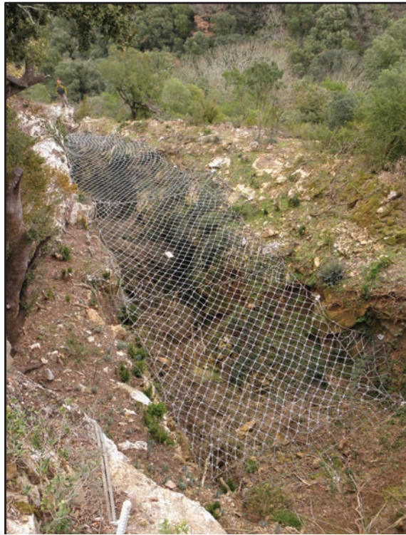
Fig. 219 : Grand Barrenc, vue d'ensemble de l'ouvrage (un prospecteur donne l'échelle à l'extrémité de la tranchée).
