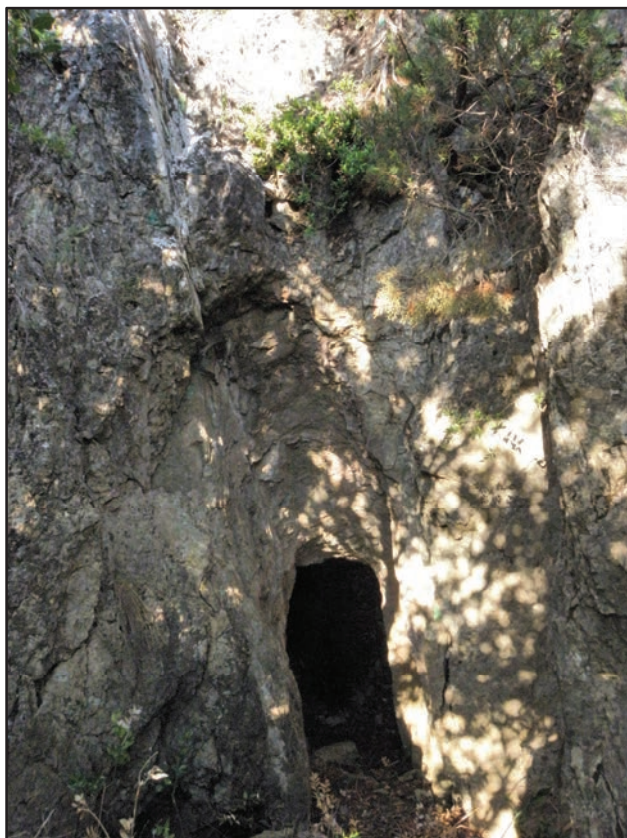
Fig. 146 : Esquina d'Ase 21-22, galerie creusée au toit du filon O-E.
