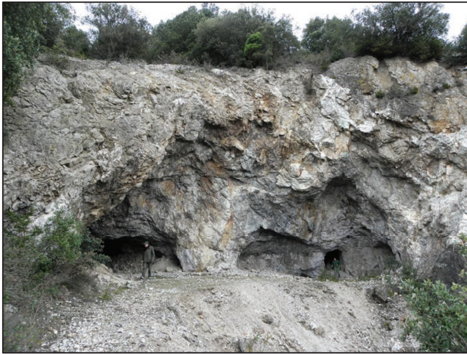
Fig. 173 : Saint-Estèbe 1, vue d'ensemble du grand chantier à ciel ouvert contemporain (XX ème s.)
