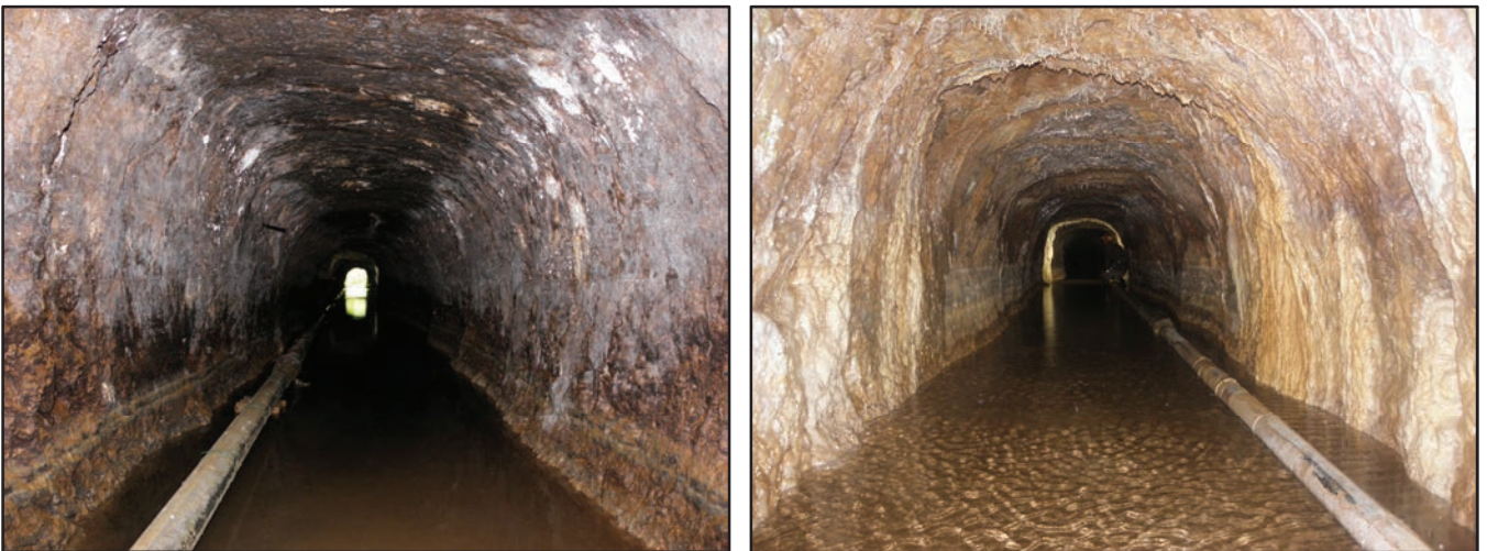
Fig. 189 : galerie de la Canal, tronçon à section arrondie.
