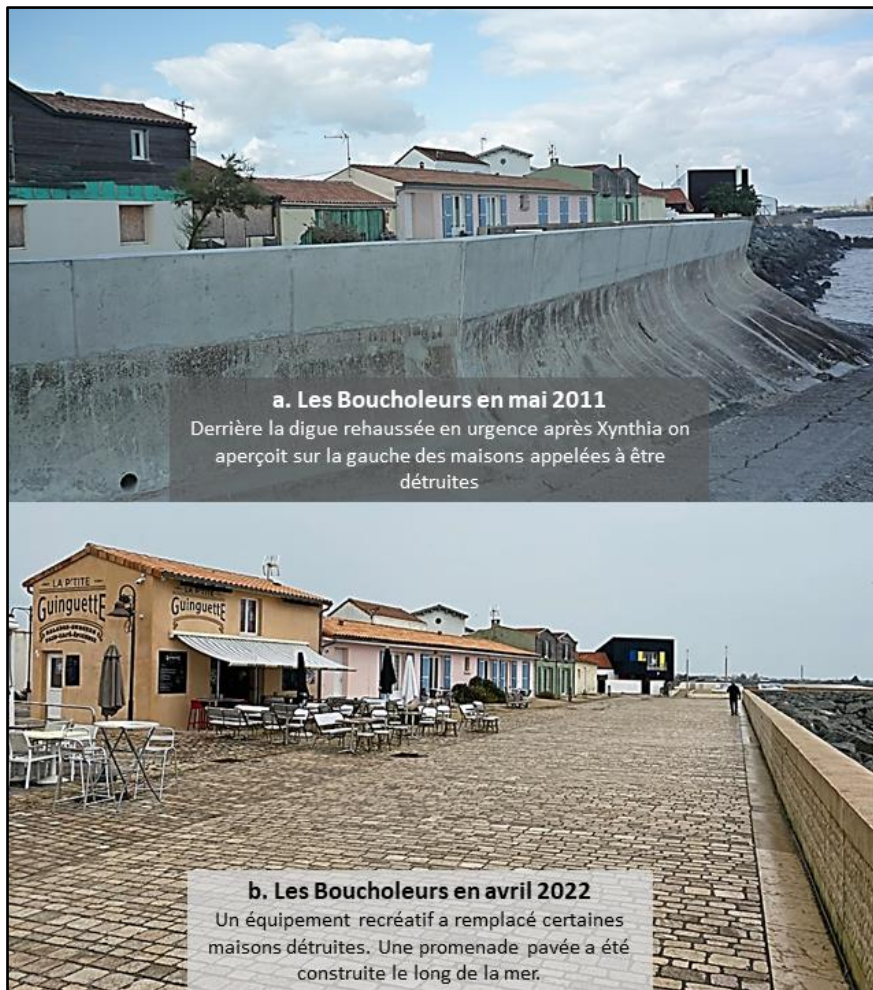
Figure 37. Évolution des attributs du quartier des Boucholeurs touché par la tempête Xynthia
