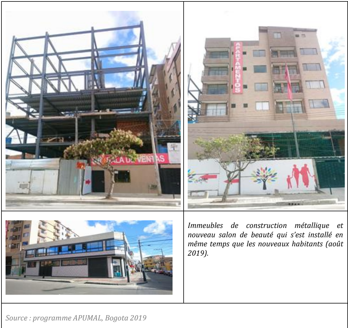
Figure 40 : Un exemple du changement à l'intérieur d'un îlot de la calle 13 Sur
