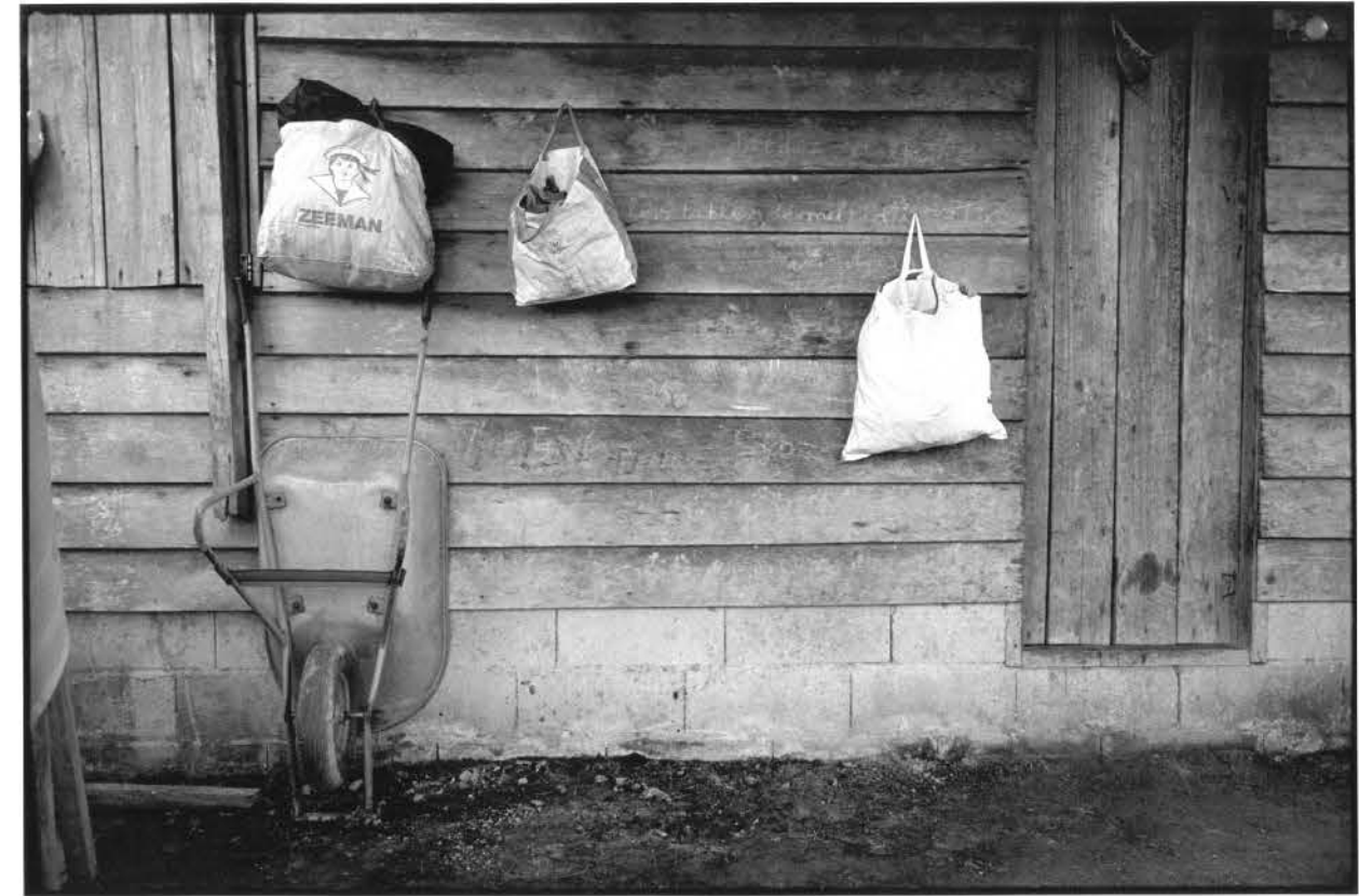
Commune de Saint-Laurent-du-Maroni, quartier auto-construit de Paul Isnard, 2019_Maison d'habitation (sous-bassement en parpaings de ciment et ossature en bois), . Tirage analogique sur papier gélatino-bromure, format 30x40 cm
