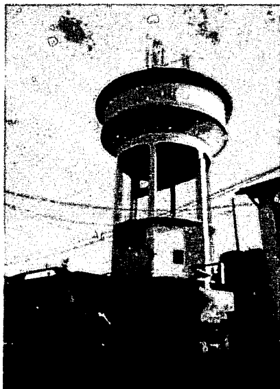
Planche n°5 : Deux exemples de château d'eau
