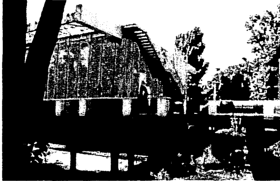
2/ Photo prise du même endroit : l'usine, fermée, ressemble davantage à une station d'épuration qu'à une usine de production d'eau potable.
