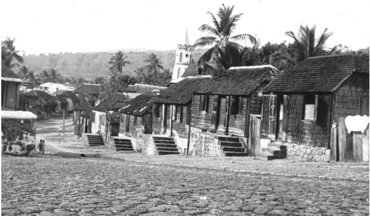
Figure 58 – Quelques ti kai le long d'une rue pavée de Roseau en mai 1899. Dans cette version, les fondations surélevées sont en pierre en lieu de pilotis en bois. Photographie de Henri Salles (1868-1929), reproduction par Radiguet et Massiot. Bibliothèque nationale de France (gallica.bnf.fr). Accessible à https://gallica.bnf.fr/ark:/12148/btv1b5965978x .
