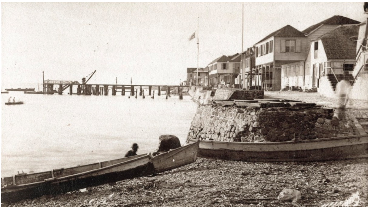
Figure 86 – Le front de mer de Roseau autour de 1890. Le terrassement et la mise en place d'une digue en pierre maçonnée le long du rivage contribuait déjà à renforcer l'incidence de la houle contre les bâtiments de première ligne, près de 100 ans après la catastrophe du 30 septembre 1780. Auteur inconnu. The Caribbean Photo Archive . Accessible à https://flic.kr/p/NZDGkS .
