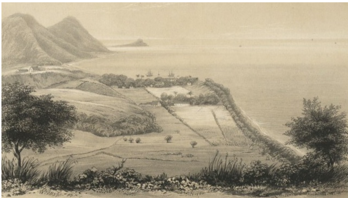
Figure 51 – Goodwill Estate , Roseau et Pointe Michel depuis le Morne Daniel. Les rangées de tamariniers plantés le long du rivage fournissent de l'ombrage à la route littorale et doivent protéger les côtes de la houle depuis la catastrophe de 1780. Au second plan, avant Roseau et ses navires amarrés au large, figurent Goodwill Estate et ses moulins à eau et à sucre au milieu des champs de cannes à sucre. Gravure, auteur inconnu (1849). Caribbean Through a Lens project collection, The National Archives UK . Accessible à https://flic.kr/p/cCbBFu .
