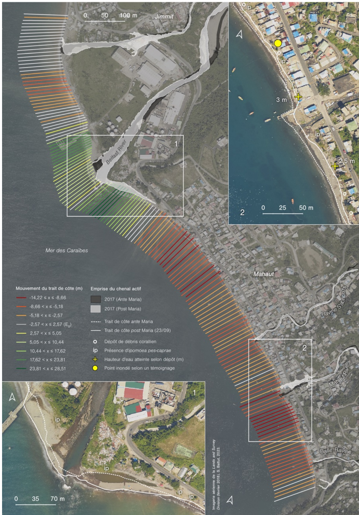
Figure 40 – Effets de l'ouragan Maria sur les formes littorales à Mahaut. Ce site offre un exemple de la variabilité locale des effets des aléas cycloniques dans un espace relativement restreint. Les effets des aléas fluvio-sédimentaires coexistent avec les conséquences des aléas météo-marins sur les paysages côtiers. L'évolution de la position du trait de côte est représentée grâce aux valeurs NSM entre le 15/09/2017 et le 23/09/2017. Méthode de discrétisation utilisée : seuils naturels.
