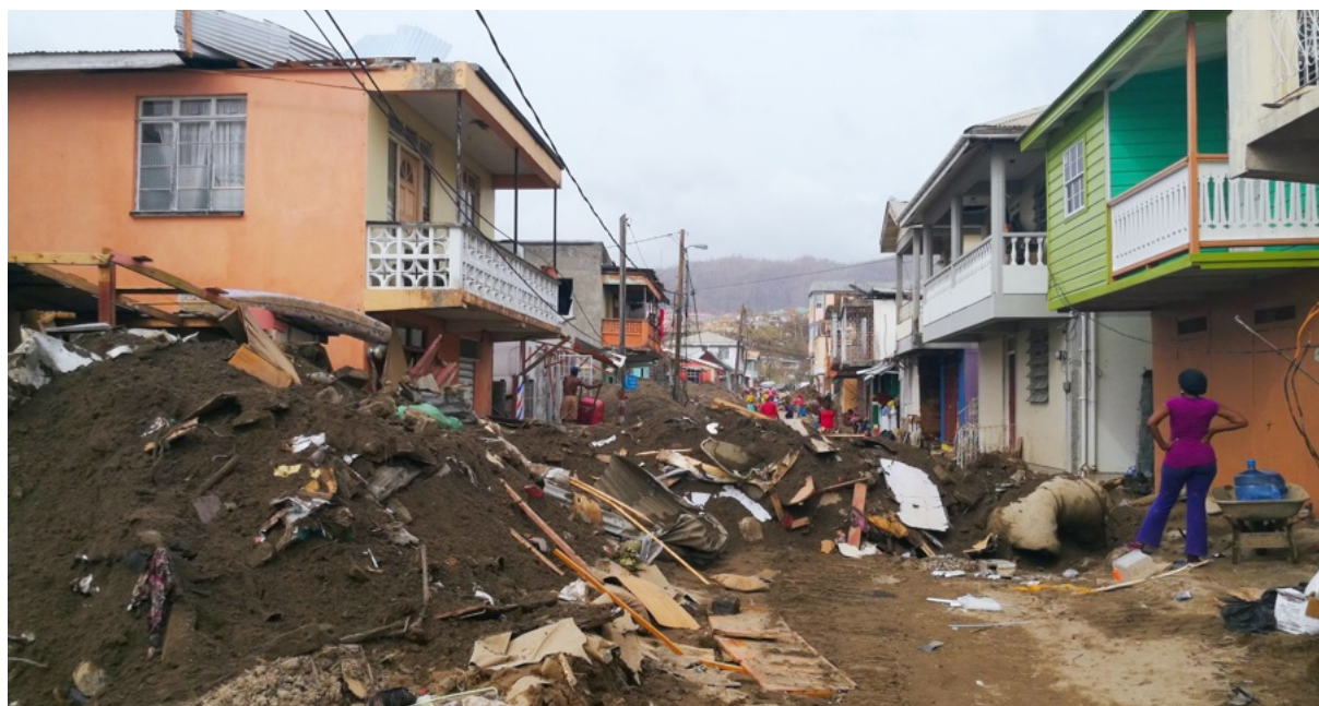
Figure 71 – Alluvionnement d'une rue à Roseau par la crue de la Roseau river lors du passage de l'ouragan Maria. UK Department for International Development, septembre 2017. Accessible à https://flic.kr/ps/dyvHy .
