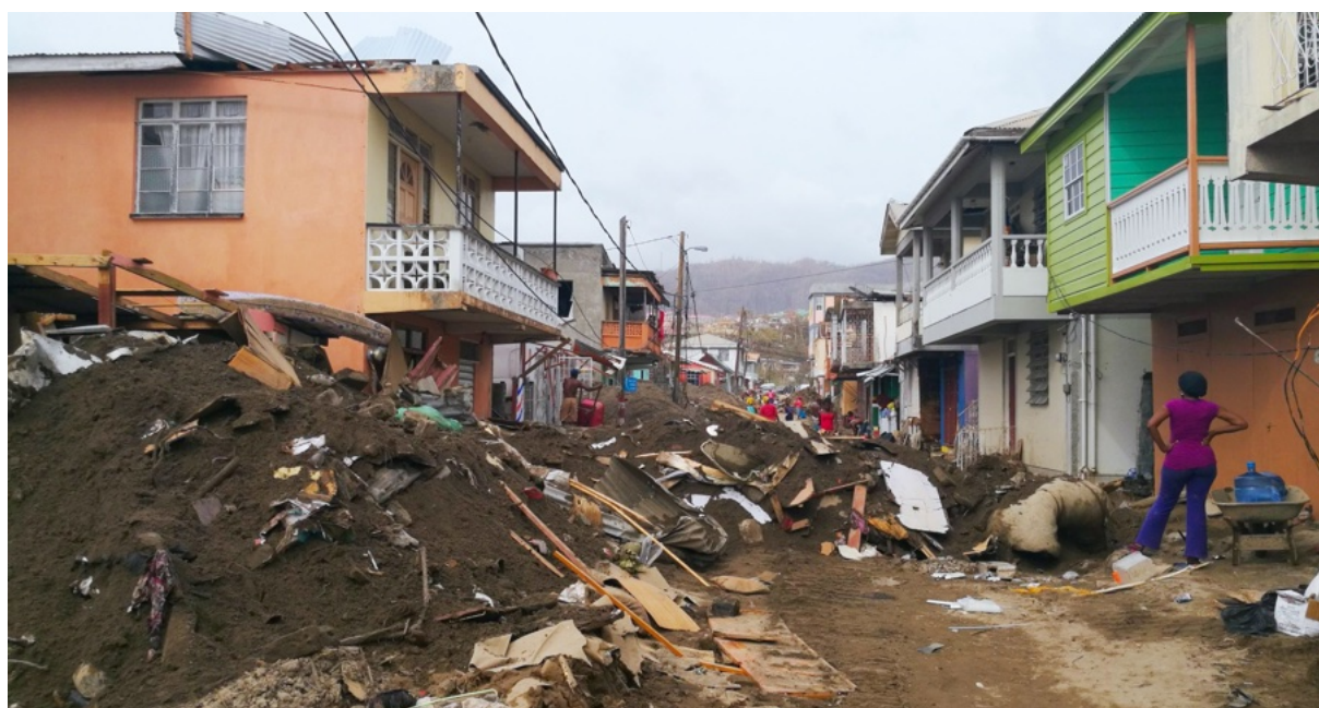
Figure 71 – Alluvionnement d'une rue à Roseau par la crue de la Roseau river lors du passage de l'ouragan Maria. UK Department for International Development, septembre 2017. Accessible à https://flic.kr/ps/dyvHy .
