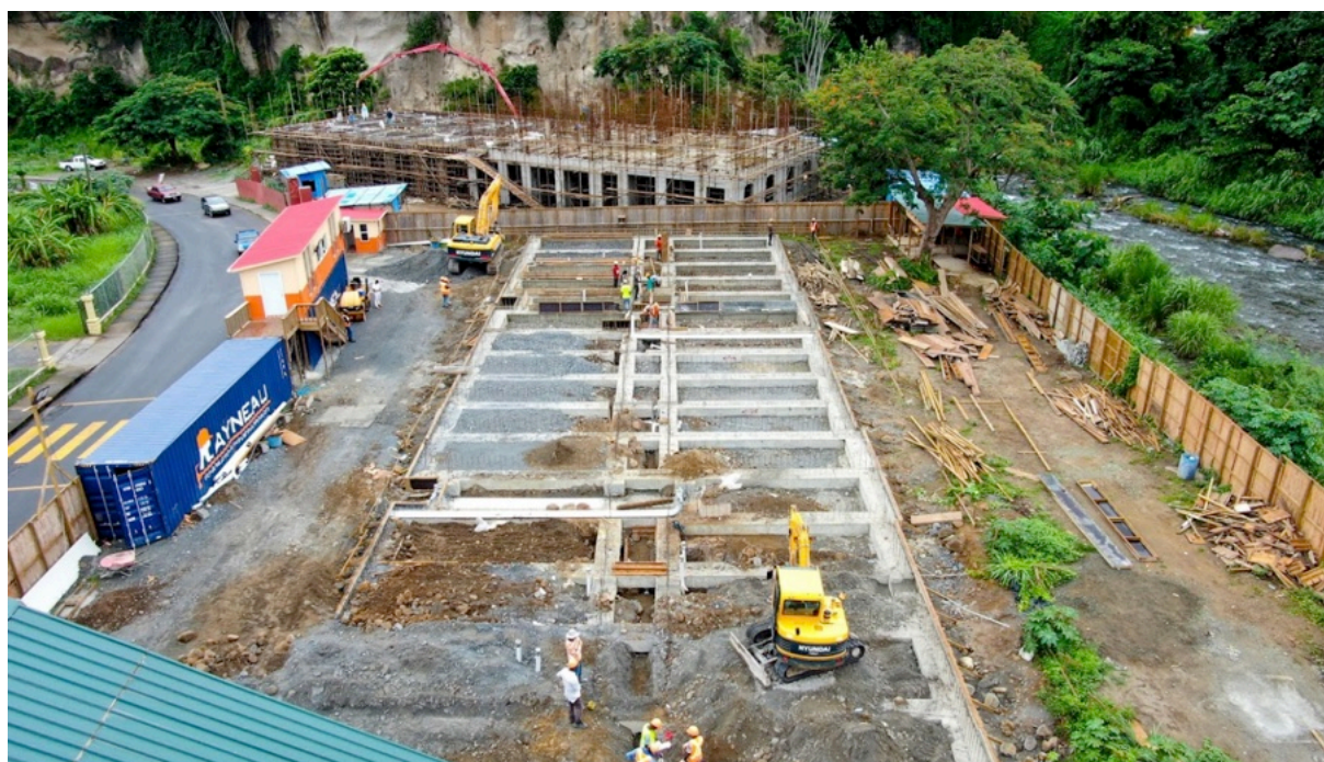
Figure 73 – Chantier du projet de développement urbain Roseau 1 sur River Street. Ces résidences destinées à accueillir les personnes que l'ouragan Maria a privé de leur logement ont été paradoxalement implantées dans un des secteurs les plus exposés aux crues, à seulement quelques mètres du fleuve Roseau. À ce jour, ces bâtiments ne présentent pas de caractéristiques architecturales de mitigation au risque inondation, et le niveau inférieur de la résidence du second plan, occupé par des logements, n'est surélevé que de près de 2 mètres par rapport au niveau d'étiage du cours d'eau. Photographie de Info Housing Développement , accessible à https://t.ly/ZE2d9 .
