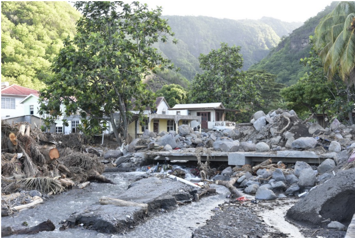
Figure 84 – Accumulations de blocs et de débris végétaux à l’origine de l’obstruction d’un pont à Colihaut suite au passage de la tempête tropicale Erika. En entravant les écoulements, la structure a entraîné l’élévation locale des hauteurs d’eau et le contournement latéral par les eaux de ce point de résistance. En arrière-plan, les versants escarpés de la vallée rendent compte de la topographie propice à la sédimentation du bassin versant de la Colihaut river. Photographie prise le 5 septembre 2015 lors d’une visite du Premier Ministre Roosevelt Skerrit. Accessible à https://flic.kr/p/xifzVw .
