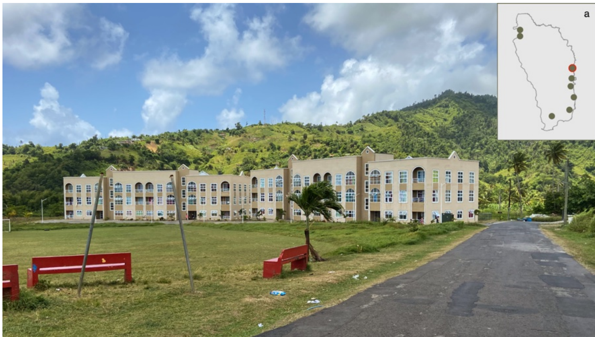
Figure 95 – Complexe de relocalisation nouvellement construit à Castle Bruce. Comme la plupart d’autres résidences de ce type construites après le passage de l’ouragan Maria pour reloger les foyers sans logement ou pour délocaliser les villages les plus exposés, ces résidences collectives sont construites à l’extérieur des tissus urbains locaux. Ils ne correspondent pas aux habitudes et aux pratiques de l’espace de la case créole majoritaire dans cette partie de la Dominique. Comme la majorité des autres projets de relogement, le complexe de Castle Bruce (détouré en rouge) se trouve sur la côte est (a). S. Battut, juin 2021.
