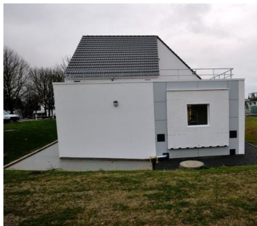
FIGURE 2.18 – Photographie de la façade extérieure Ouest de BESTLab ( Rodler, 2014 )
