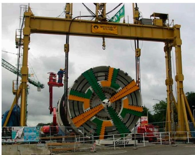
Figure 79 : Roue de coupe du tunnelier à pression de terre du lot 5
