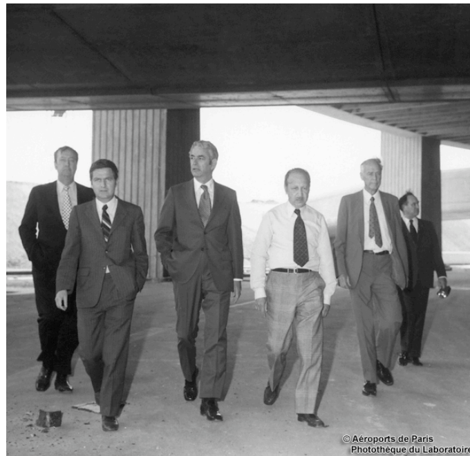
Fig 31: Aéroport de Roissy, Visite de presse du chantier, 1971-1972 Source Photothèque Aéroports de Paris
