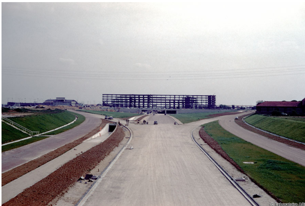
Fig 21: Publicités d'Aéroport de Paris pour l'ouverture de la nouvelle aéro-gare d'Orly Sud En bas, La nouvelle aéro-gare d'Orly Sud en construction, surplombant la Nationale 7 qui a été déviée, 1958, Photographie Jean-Jacques Moreau Source Archives et Photothèque d'Aéroports de Paris.
