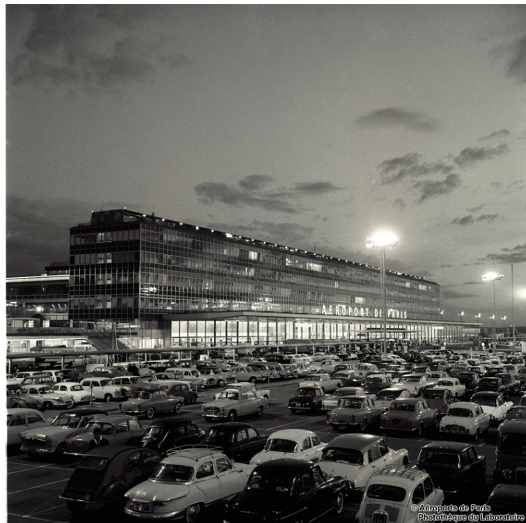
Fig 12.1: Orly Sud, Premiers visiteurs, circa 1961 Source Photothèque Aéroports de Paris
