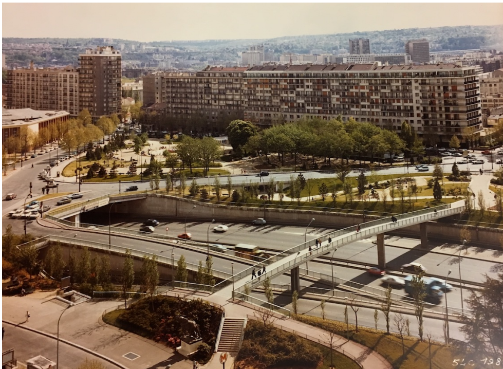
Fig 19: En haut, Porte de la Chapelle, 13 juin 1978; En bas, Boulevard périphérique de Paris, Passage du Boulevard à la porte de Saint-Cloud, non daté (1981?) Cliché Photo industrielle H.Baranger et Compagnie, Collection Pavillon de l'Arsenal
