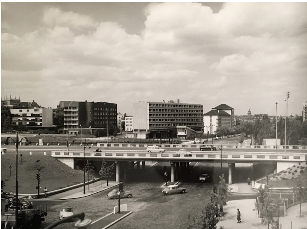
Fig 18.1: En haut, Boulevard périphérique Sud, Poterne des peupliers, mai 1961; En bas, Boulevard périphérique Sud, Pont, Porte de Gentilly, mai 1961. Clichés Jean-Claude Bollier, Collection Pavillon de l'Arsenal
