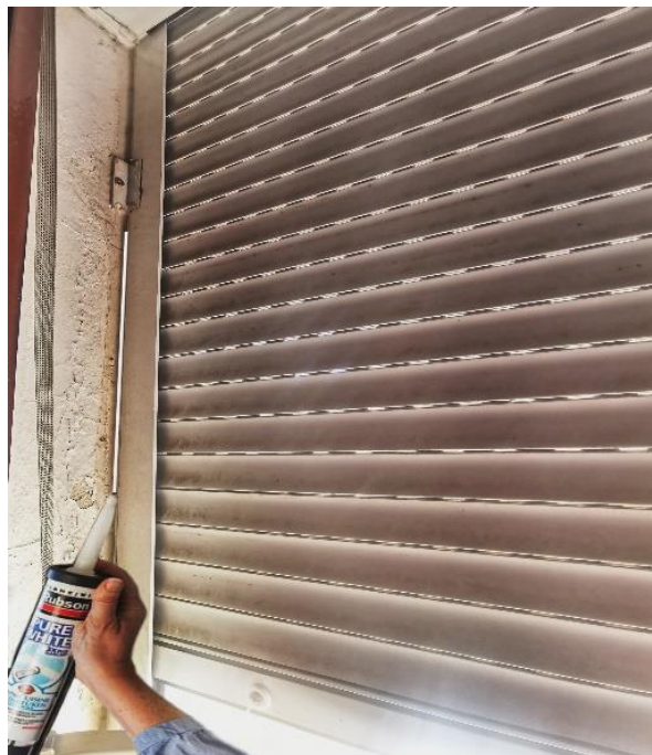
Figure 128 : Scellement de la persienne Aluminium avec le joint silicone. Source : Auteur, 2022
