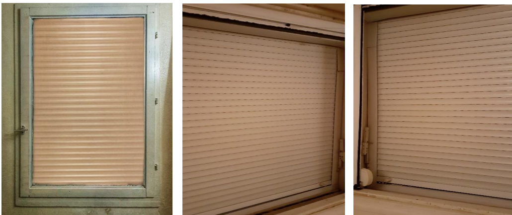
Figure 124 : Vue d'intérieur sur la fenêtre avec persienne Aluminium fermée. Source : Auteur, 2022
