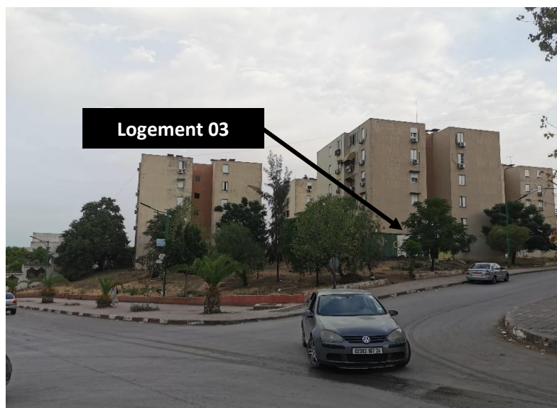
Figure 79 : Illustration de l'environnement immédiat du bâtiment bloc 07. Source : Auteur, 2022
