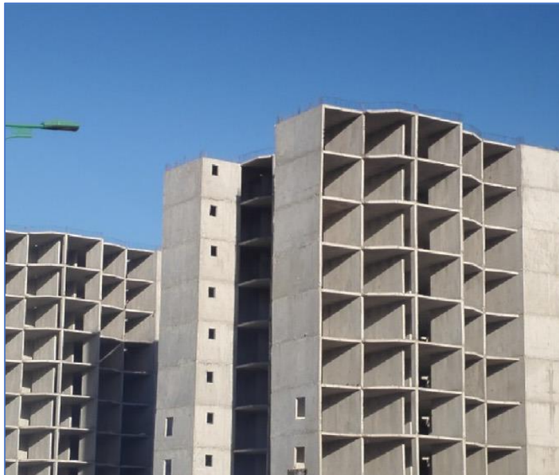
Figure 149 : Vue sur le système d'ossature en tunnel en béton armé. Source : Auteur, 2022
