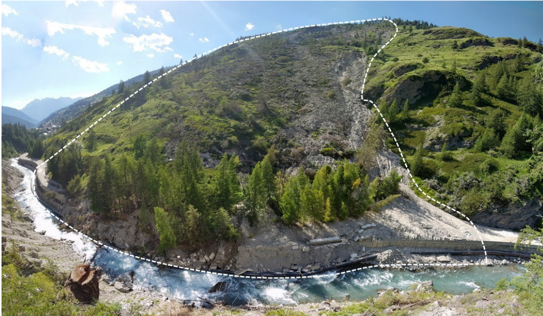
Figure 1 : Exemple de glissement de terrain après destruction de la route en aval. La pente instable délimitée en pointillés s'étend sur une largeur de 500 mètres. Pas de l'Ours, Aiguilles, Hautes-Alpes, France, le 27/07/2018.
