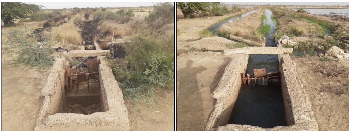
Après mise en eau (b)
