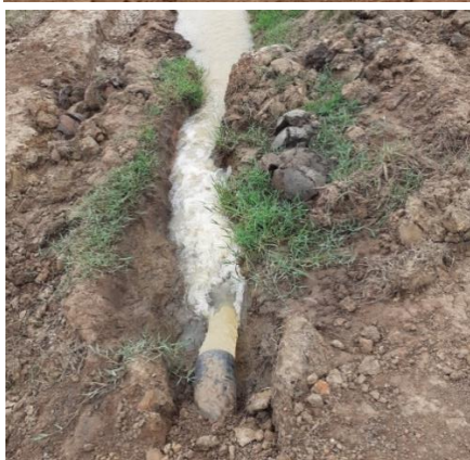
c) tuyau alimentant un canal d'irrigation
