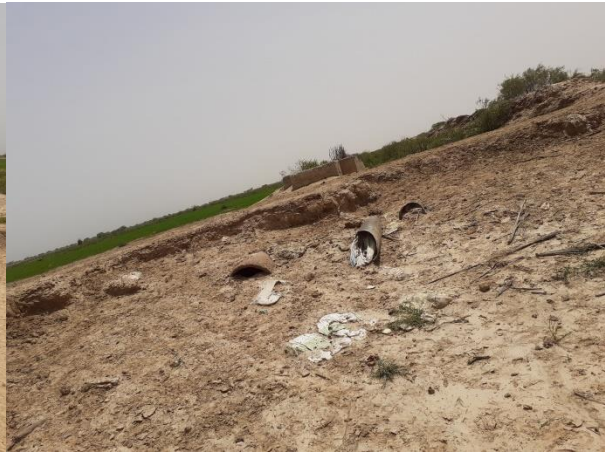
Photo 27 : Collecteur principal de la cuvette de GDT
