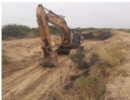
Photo 28 : Réfection des canaux de la cuvette de Grande Digue Tellel
