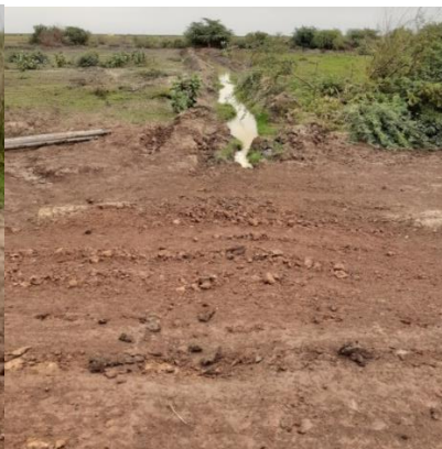
b) traversée de l'eau sous la route latéritique
