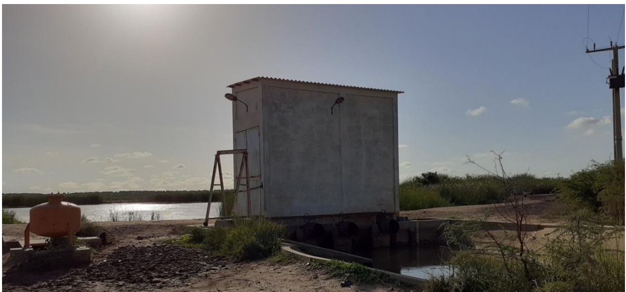
Station de pompage du casier de Diagambal, sur le Lampsar, cliché Sylla E.H.M, septembre 2019
