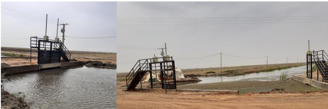
Photo 13 : Dalots vannés avec franchissement dans le périmètre du 3 PRD
