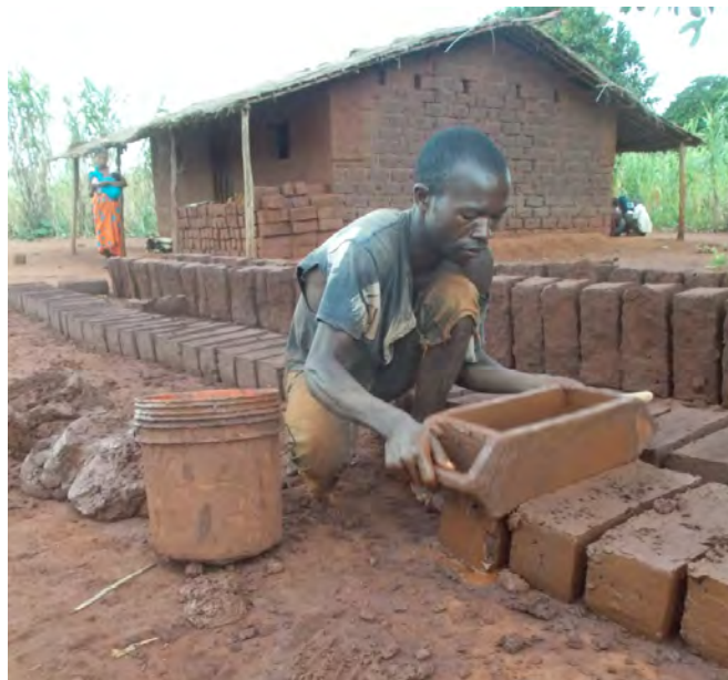
Figure 7.14.2: Photographie d'un homme produisant des briques en terre crue pour un voisin en échange d'une rémunération. (Photographie N. Leblond Avril 2015.
