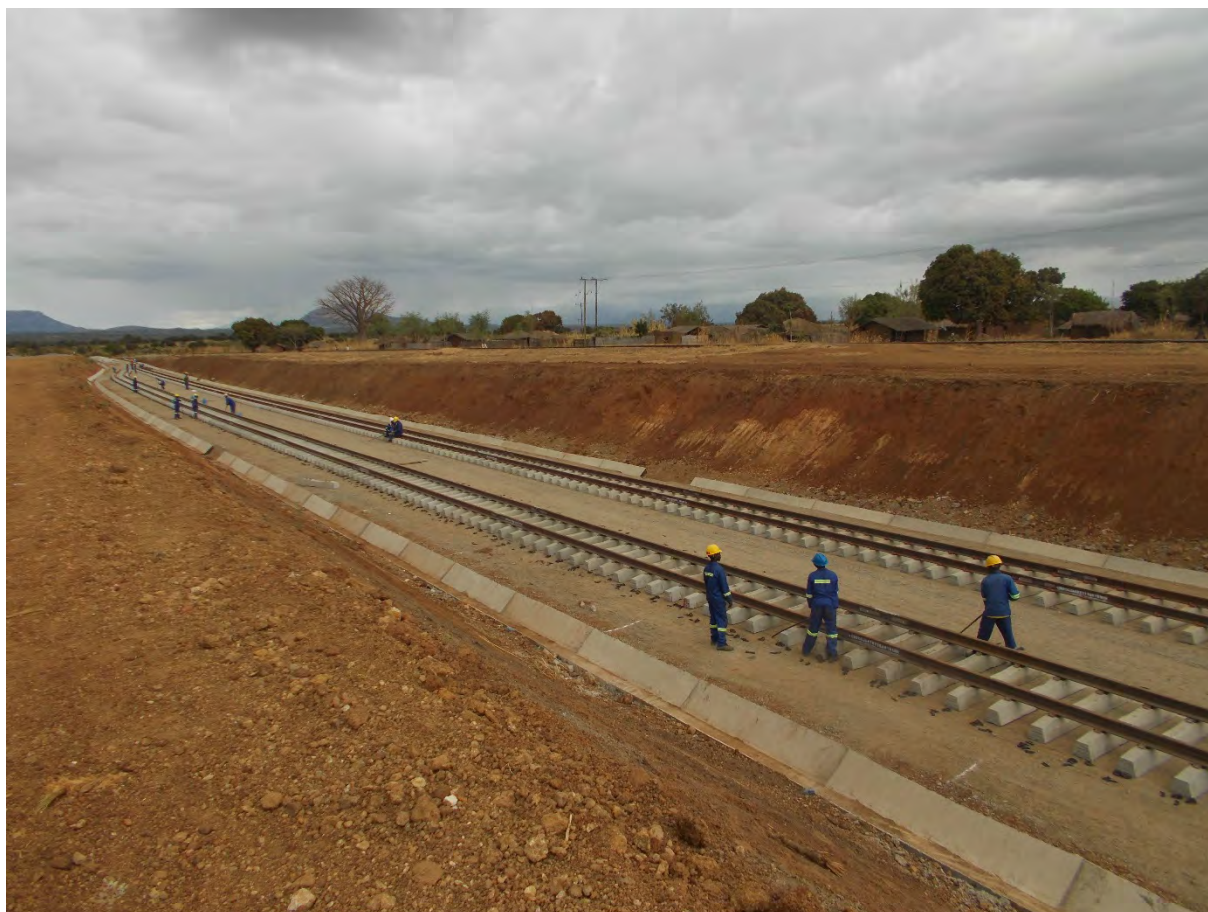
Figure 6.9 : Le dédoublement de la voie ferrée à Mutuali. Photographie de la mise en place de deux voies supplémentaires pour permettre le passage des trains de charbons. Source : N. Leblond, Mai 2015
