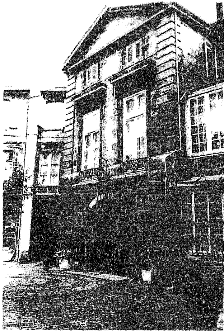
Fig. 31 - L'Hôtel de la Marine . Façade sur la cour intérieure .
