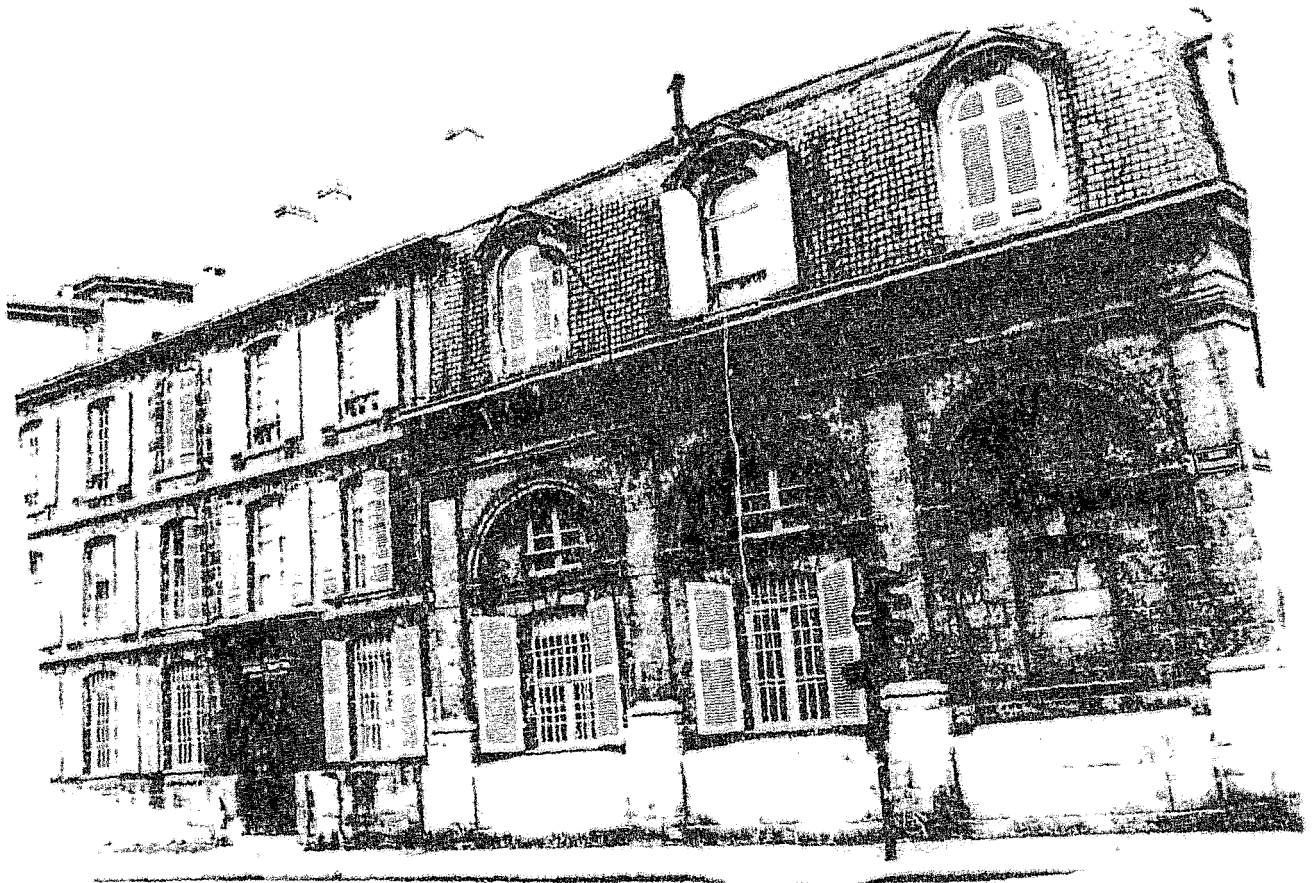
Fig. 30 - L'Hôtel de la Marine . Façade sur la rue Fondaudège .
