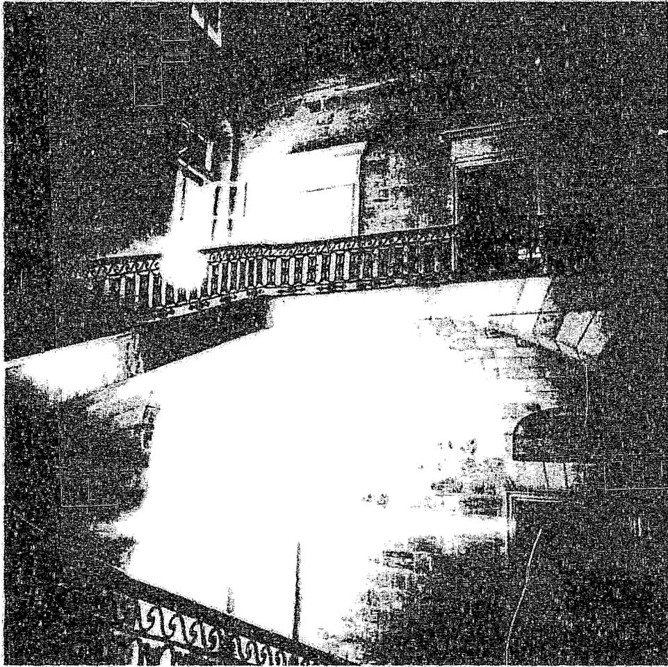
Fig. 183 - Palais Rohan. Demi-voûte en arc de cloître supportant le palier.
