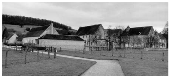
Figure 40 c Noirlac, vue générale depuis le sud ouest, 2001
