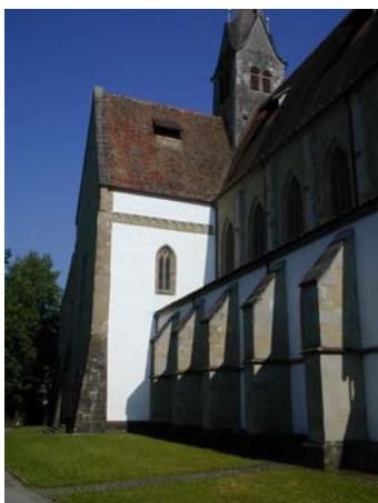
figure 38 b Cappel, façade nord de l'église, 2002
