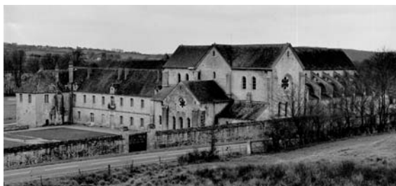
Figure 40 b Noirlac, vue générale depuis le nord est, 2001
