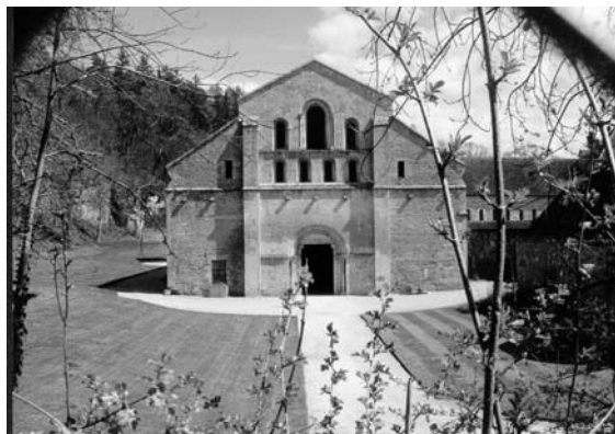
Figure 36 b Fontenay, façade occidentale de l'église 1999
