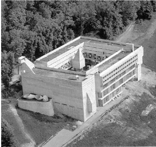
Figure 15 Vue aérienne du couvent de la Tourette, (FERRO et al. 1987, p. 76)
