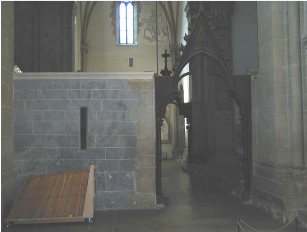
Figure 94 Cappel, vue arrière de la rangée sud des stalles au niveau de la croisée. On remarque la cloison maçonnée d'adossement et le portail gothique d'accès au choeur. 2002
