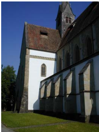
figure 38 b Cappel, façade nord de l'église, 2002
