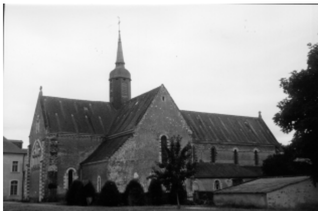
Figure 42 d Melleray, façade nord de l'abbatiale, 1999
