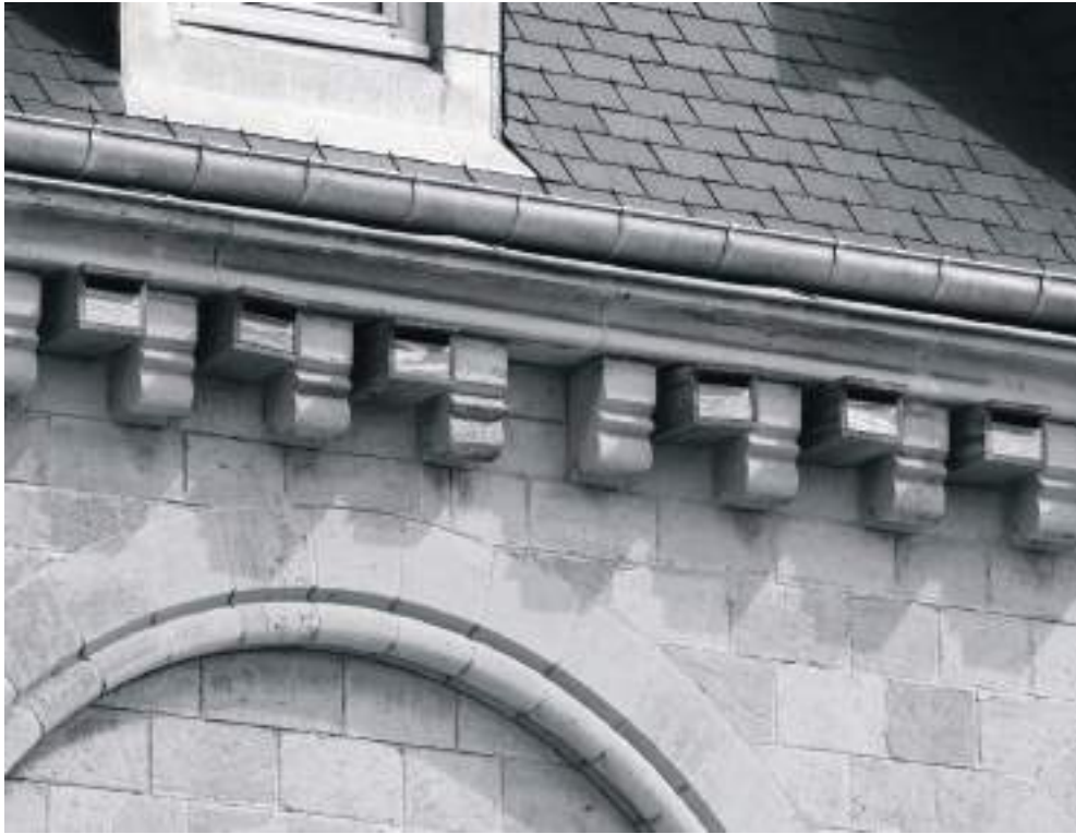
A Saint-Dizier (52), une vingtaine de nichoirs sont discrètement installés sur la façade de la Chapelle de l'ancien hôpital en cours de réhabilitation sur demande de la LPO (en 2013) à la faveur des Martinets. Photo : Michel Rollot, mai 2022.
