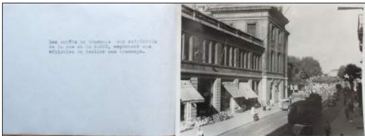
Figure 36 : Problème de circulation rue de la Barre, sd (AML 1267 WP 11/1)
