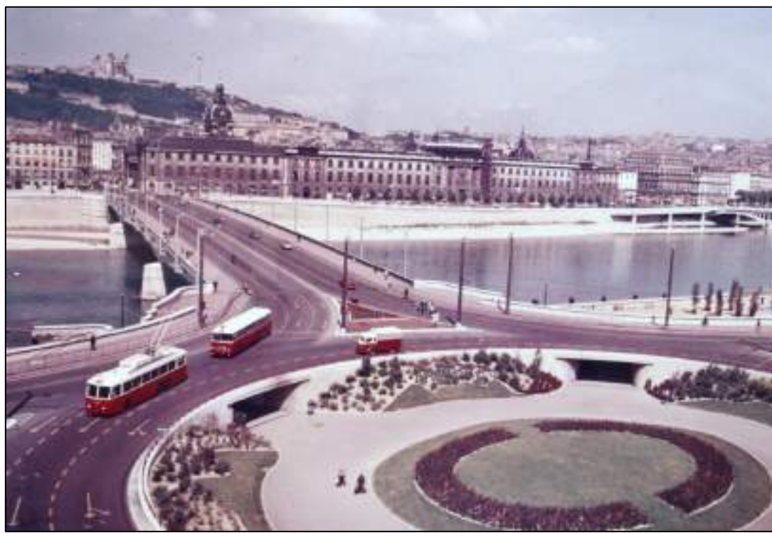
Figure 66 : Vue du pont de la Guillotière et de ses abords à son entrée Est (AML 1754 W 4)
